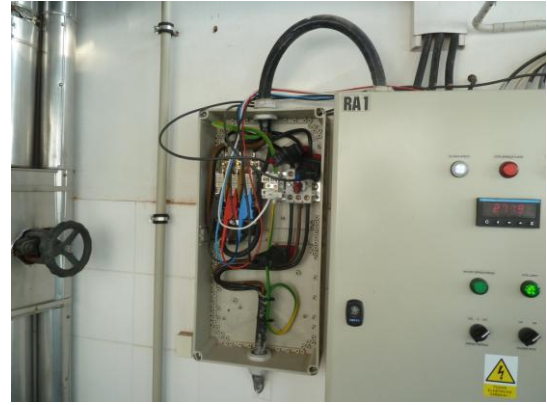
Obr. 12. Zapojení měřicího zařízení CA8332
