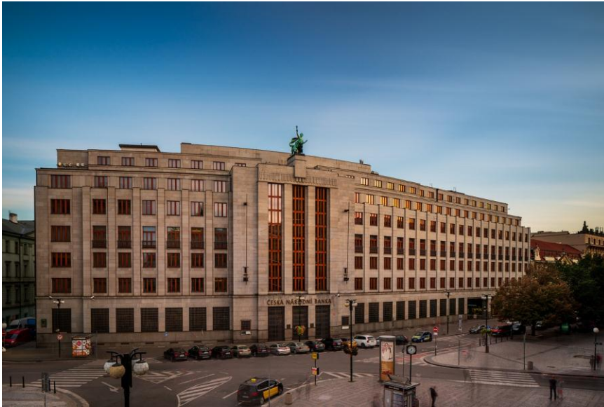
Obrázek 4: Hlavní budova ČNB Zdroj: ČNB, 2020
