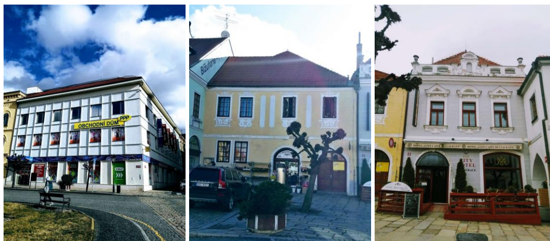
Obrázek 16,17,18: obchodní dům, dům č. 36/3, dům č. 35/1, zdroj: vlastní, 2022
