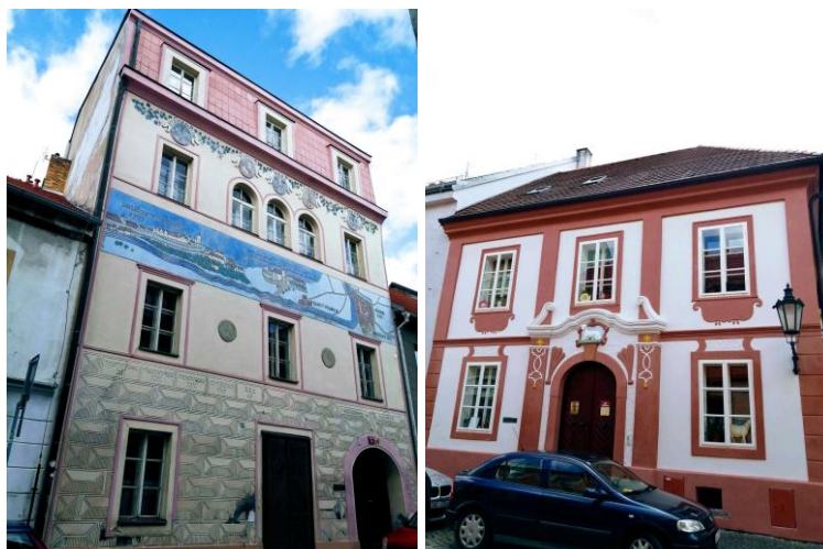
Obrázek 23,24: dům č. 153/8, dům č. 143/13, zdroj: vlastní, 2022
