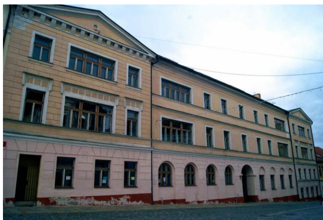
Obrázek 36: budova staré kasárny, zdroj: vlastní, 2022
