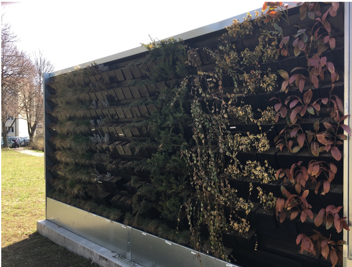
Obrázek 53: Celkový vzhled stěny v den monitoringu 3.4.2018, zdroj: autor
