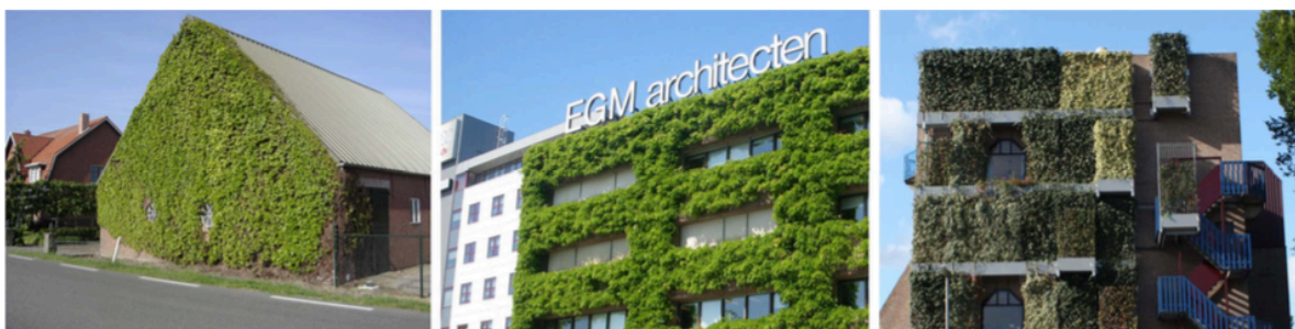
Obrázek 4: Přímý systém ozelenění (a), nepřímý systém ozelenění (b), nepřímý systém kombinovaný s kontejnery se substrátem (c), zdroj: Perini et al. (2011)
