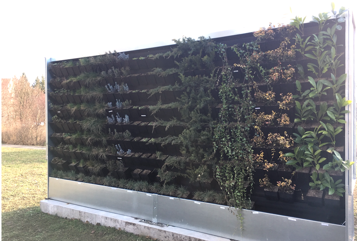
Obrázek 39: Celkový vzhled stěny v den monitoringu 30.1.2018, zdroj: autor
