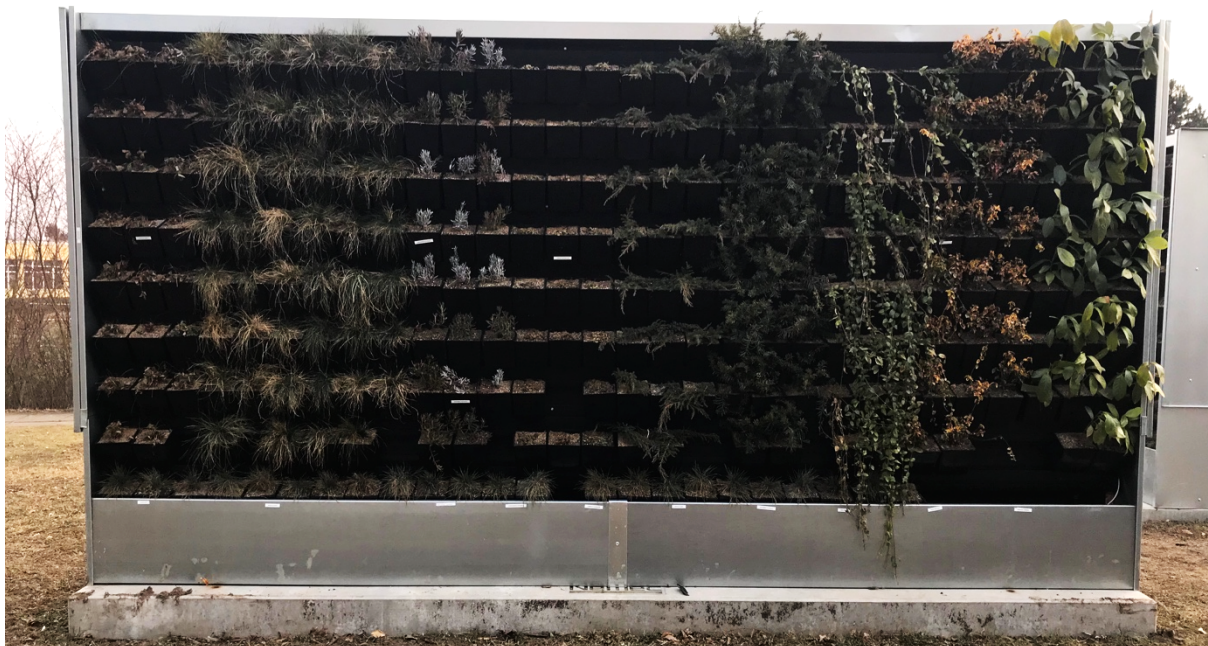
Obrázek 43: Celkový vzhled stěny v den monitoringu 27.2.2018, zdroj: autor
