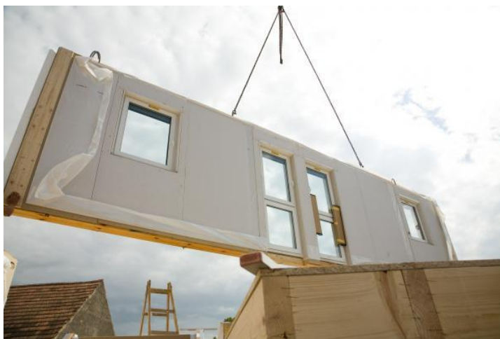
Obr. 1: Panel rámové konstrukce (www.ceskestavby.cz)
