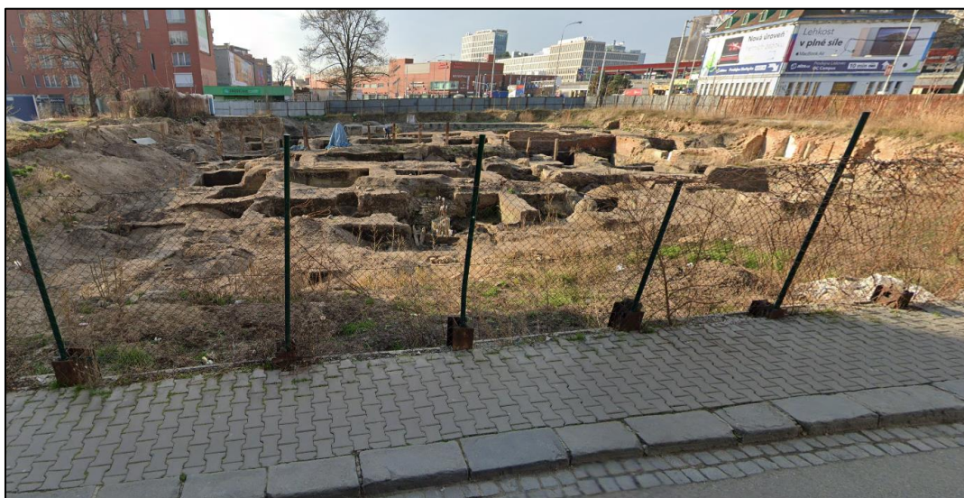
Obr. č. 9 Pohled na zbytky základových konstrukcí [31]
