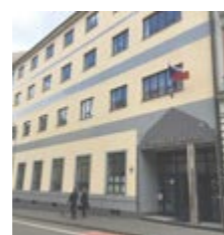
budova finančního úřadu
