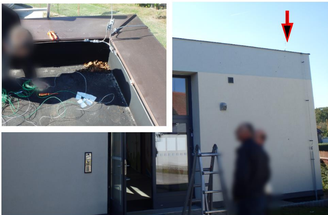
Obr. 30 Pohled na měřenou konstrukci – plochá střecha [autor]
