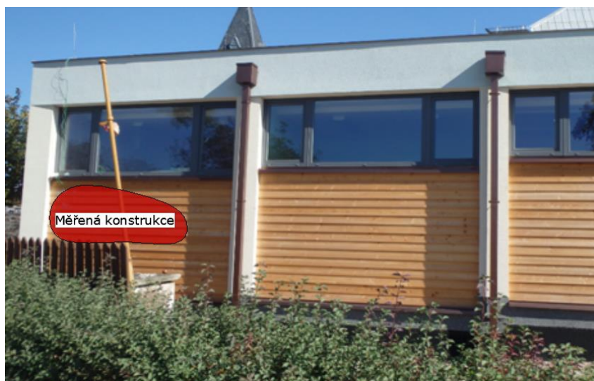
Obr. 26 Pohled na měřenou konstrukci
