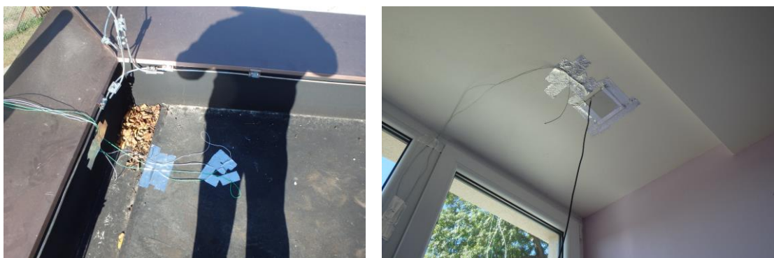
Obr. 34 Pohled na konstrukci - osazení čidel, z exteriérové a interiérové strany [autor]
