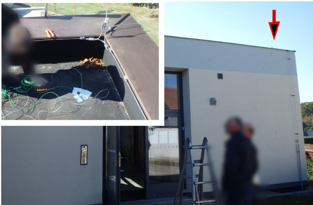
Obr. 30 Pohled na měřenou konstrukci – plochá střecha [autor]
