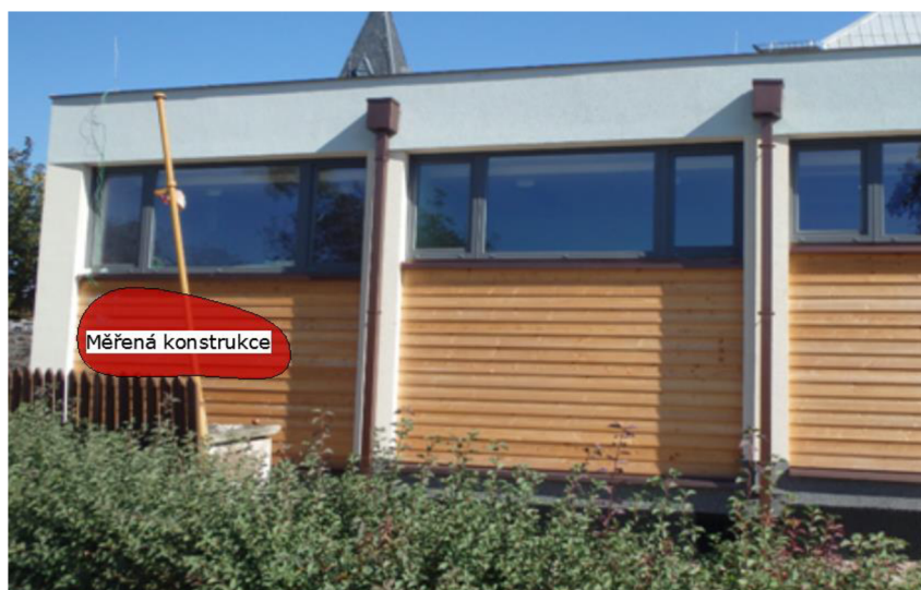
Obr. 26 Pohled na měřenou konstrukci
