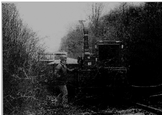
Obr. č. 4 Pohled na trať při údržbě
