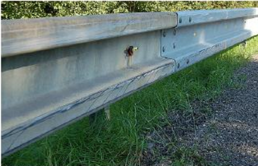
Obr. 10: Stav pravého svodidla, kde na dolním vystouplém profilu kromě černých vodorovných čar po otěru pneu jsou i stopy s částí křivek zvaných cykloida
