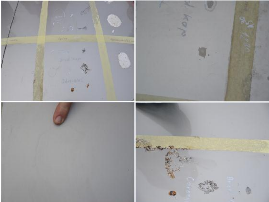
Obrázek 17: výsledné poškození po působení agresivní látky
