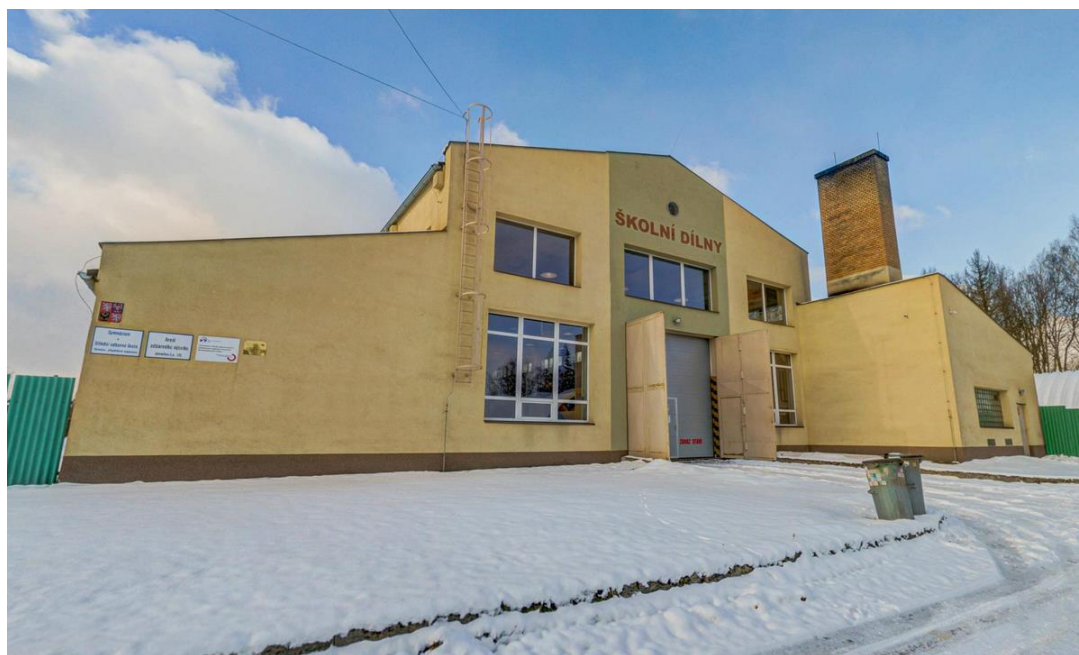
Obrázek 17: Budova školních dílen (zdroj: gymsosrym.cz)
