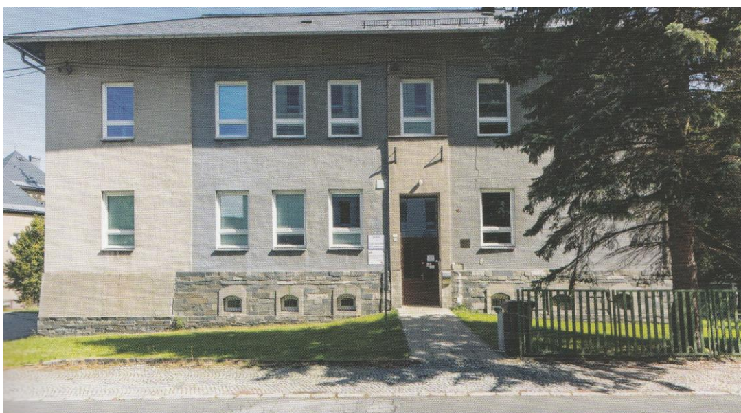
Obrázek 14: Budova SŠ Rýmařov (2020) (zdroj: Lašák, 2020)
