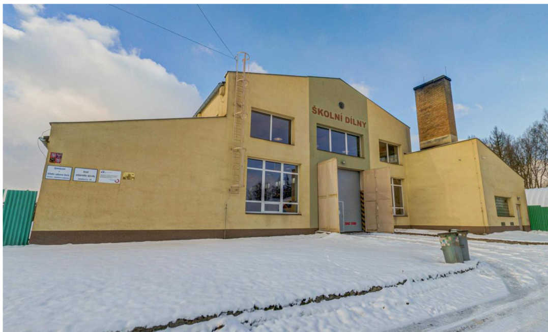
Obrázek 17: Budova školních dílen (zdroj: gymsosrym.cz)
