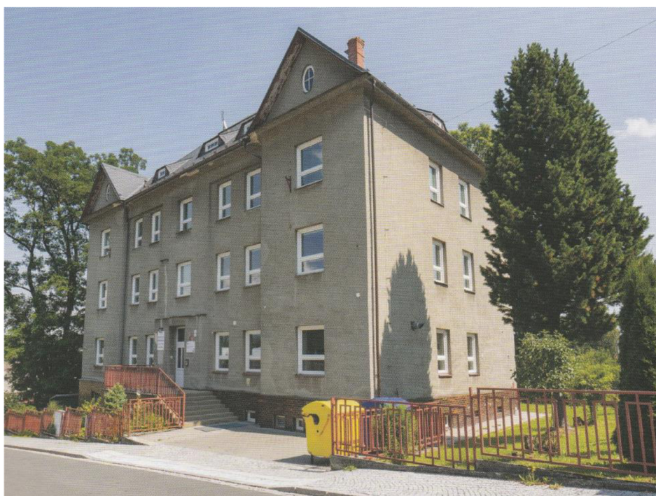
Obrázek 16: Budova Internátu a jídelny SŠ Rýmařov (2020) (zdroj: Lašák, 2020)
