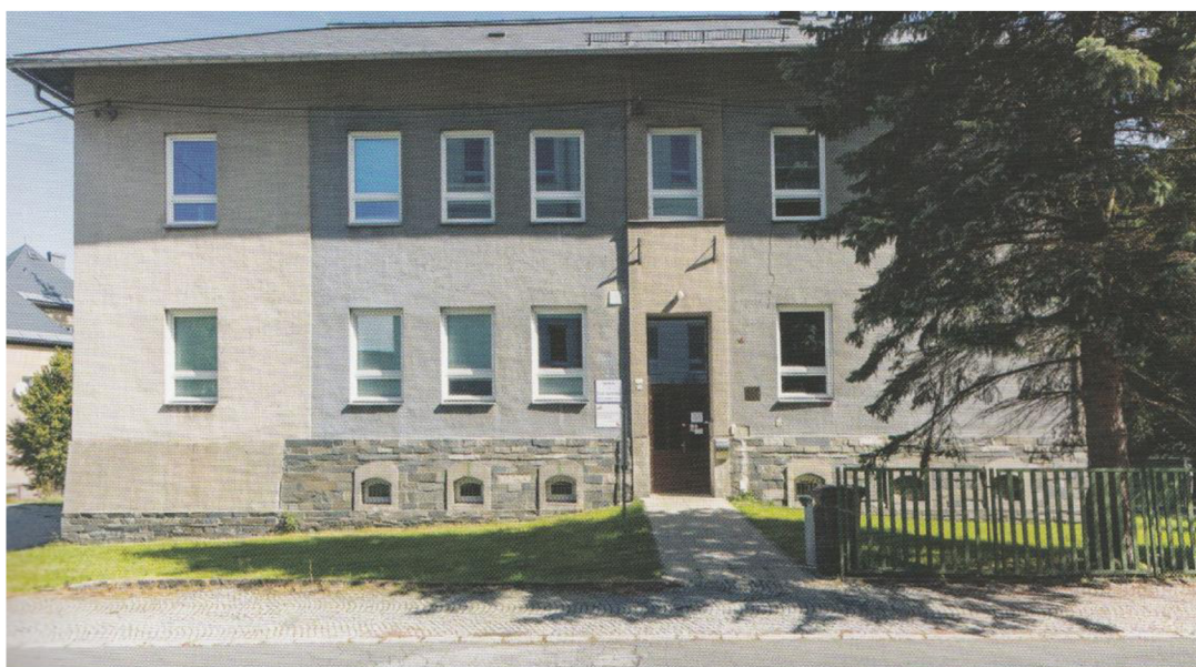
Obrázek 14: Budova SŠ Rýmařov (2020) (zdroj: Lašák, 2020)
