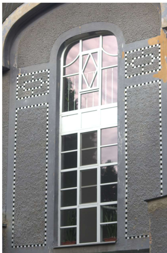
XIX – Hubert Gessner, pásy ztvárňující geometrický ornament, 1909, mozaika, průčelí budovy kuchyně s pekárnou, Psychiatrická nemocnice Kroměříž.
