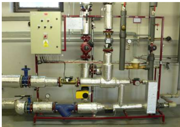
Obrázek 15 Tlakově závislá předávací stanice [17]
