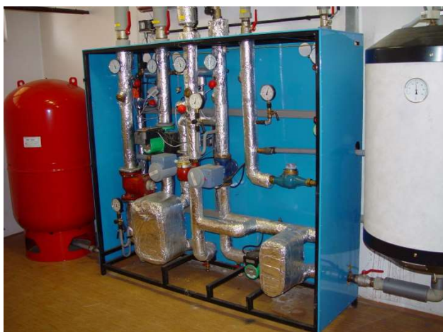
Obrázek 14 Tlakově nezávislá předávací stanice [16]
