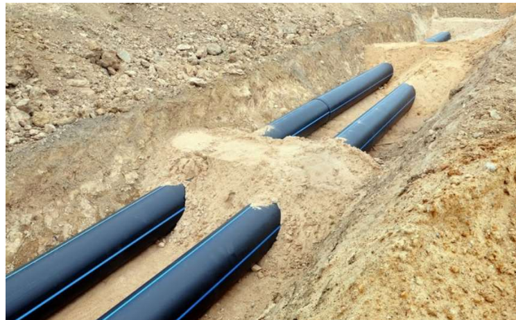
Obrázek 12 Bezkanálové uložení tepelné sítě [14]
