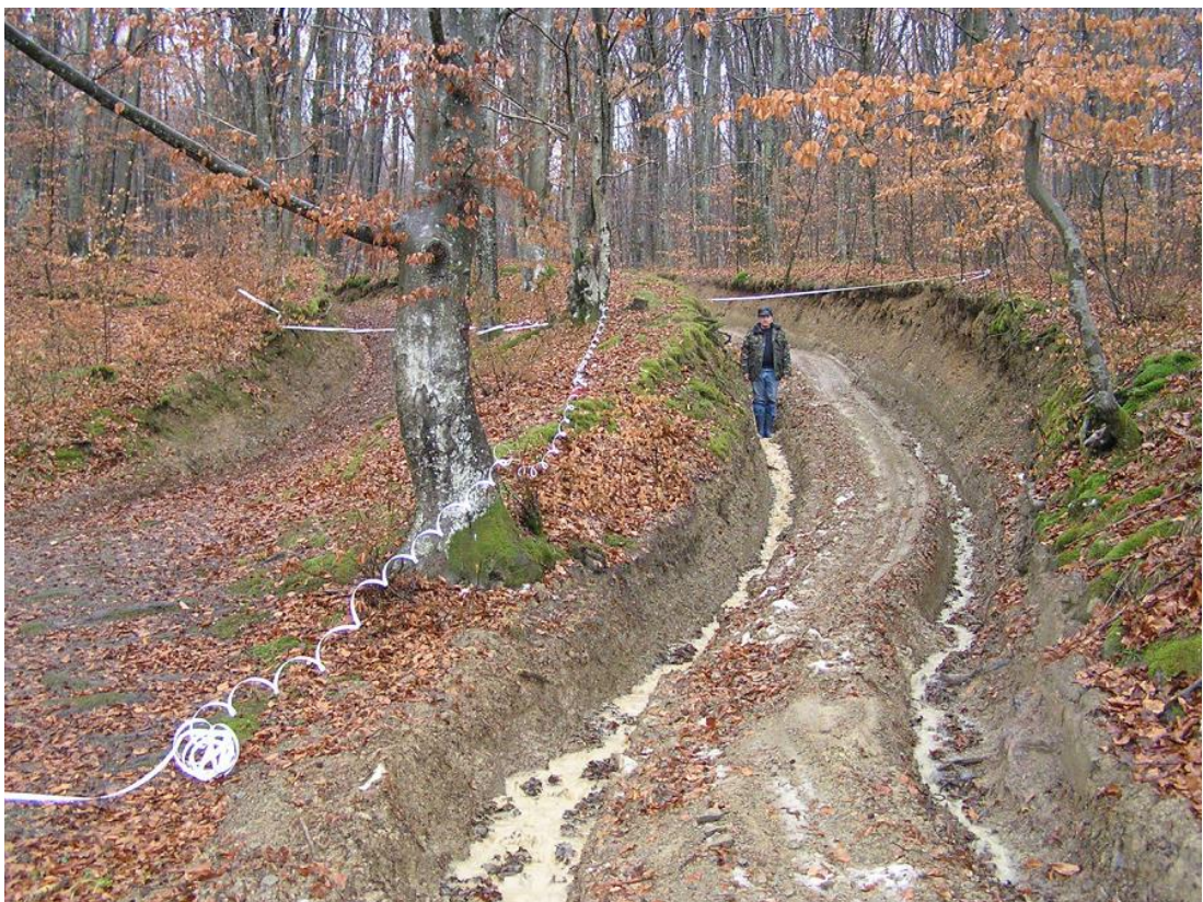
Obr. č. 40 - eroze na lesní svážnici. (Štefan Vaľo, 2017).
