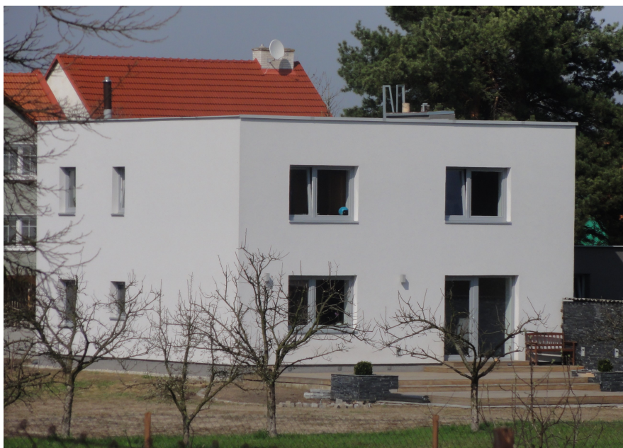
Foto 7. Troubky: novostavba domu v rizikové zóně: postačí takto zvýšené přízemí? (červen 2013)
