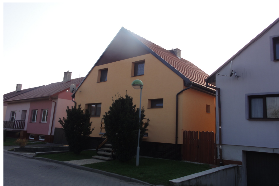
Foto 8. Zářiči: domy se zvýšeným obytným přízemím i sklepem (červen 2013)
