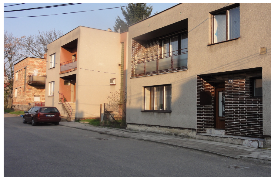
Foto 4. Zářičí: vlevo dům se zvýšením obytným přízemím, vpravo bez (červen 2013)
