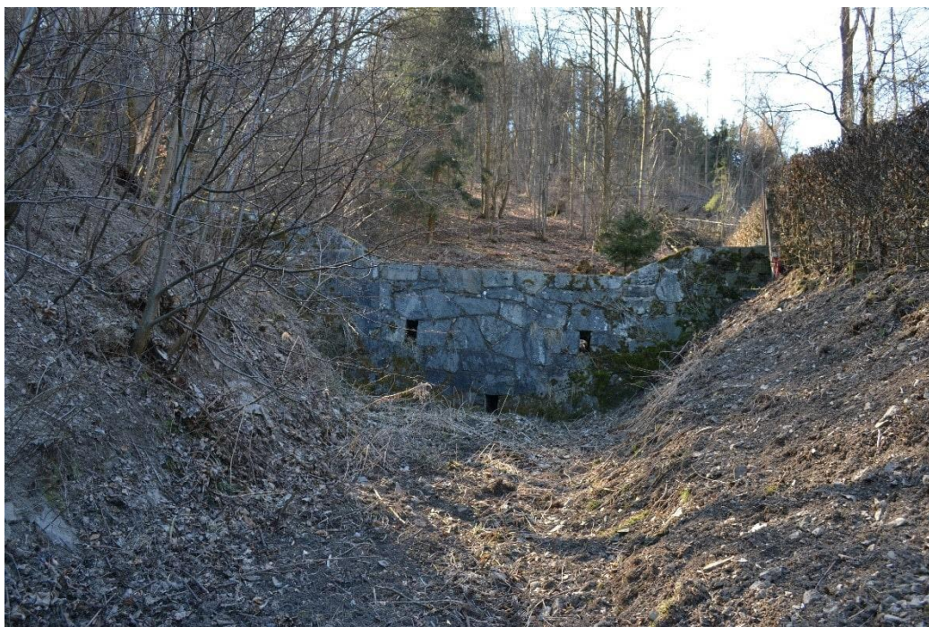
Příloha 31: Kamenná přehrážka na lokalitě Pustověty 3. Výška v přepadové hraně 2,5 m; šířka v přepadové hraně 4,1 m; celková šířka 12 m.
