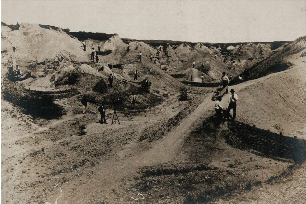
Příloha 1: Zpevňování strží v permokarbonských pískovcích povodí Rakovnického potoka vrbovými záplety. V pozdější fázi se strže stabilizovaly zalesněním.
