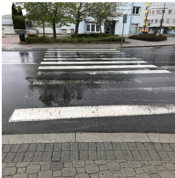
Obr. 18: První z přechodů pro chodce vedoucí k poliklinice
