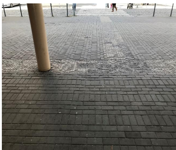
Obr. 28: Navazující signální pás směřující k přechodu pro chodce na náměstí Svobody
