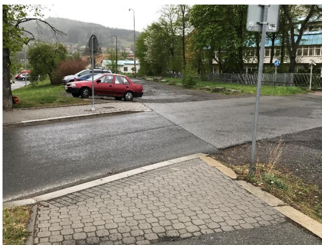
Obr. 12: Chodník směřující do vozovky
