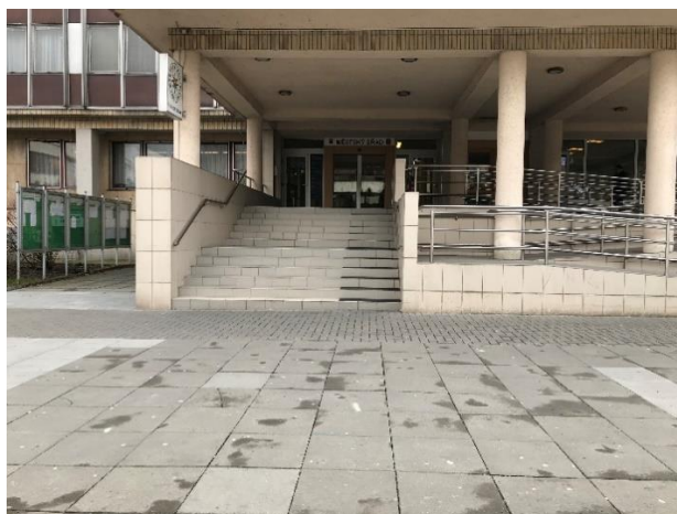
Obr. 31: Pohled na hlavní vchod Městského úřadu
