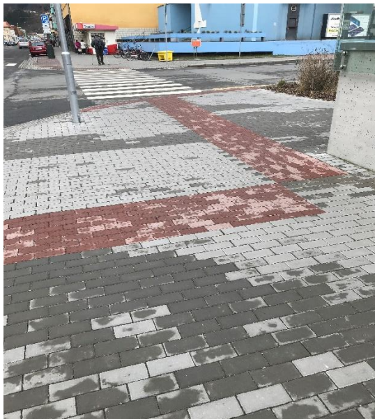
Obr. 23: Přechod pro chodce od věžového domu směrem ke Smetanově galerii
