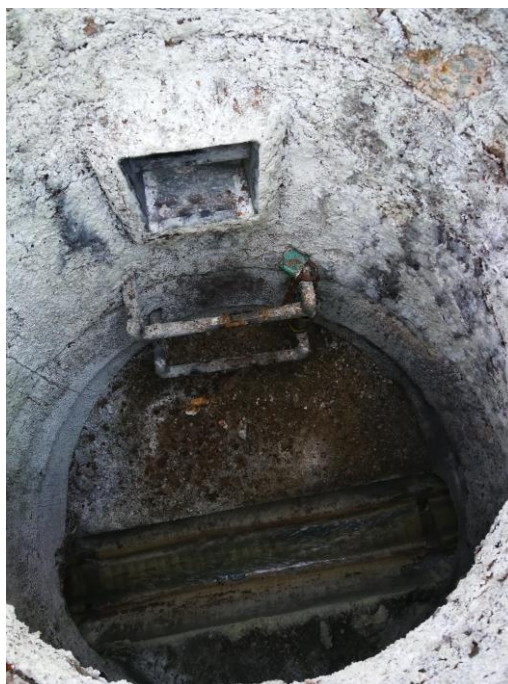
Obrázek 31 Kanalizační šachta v Rosicích 4. prosince 2019
