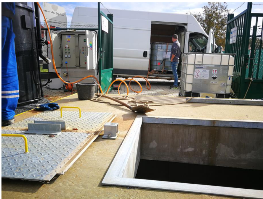
Obrázek 23 Odčerpávání síranu železitého na ČS OV Neslovice
