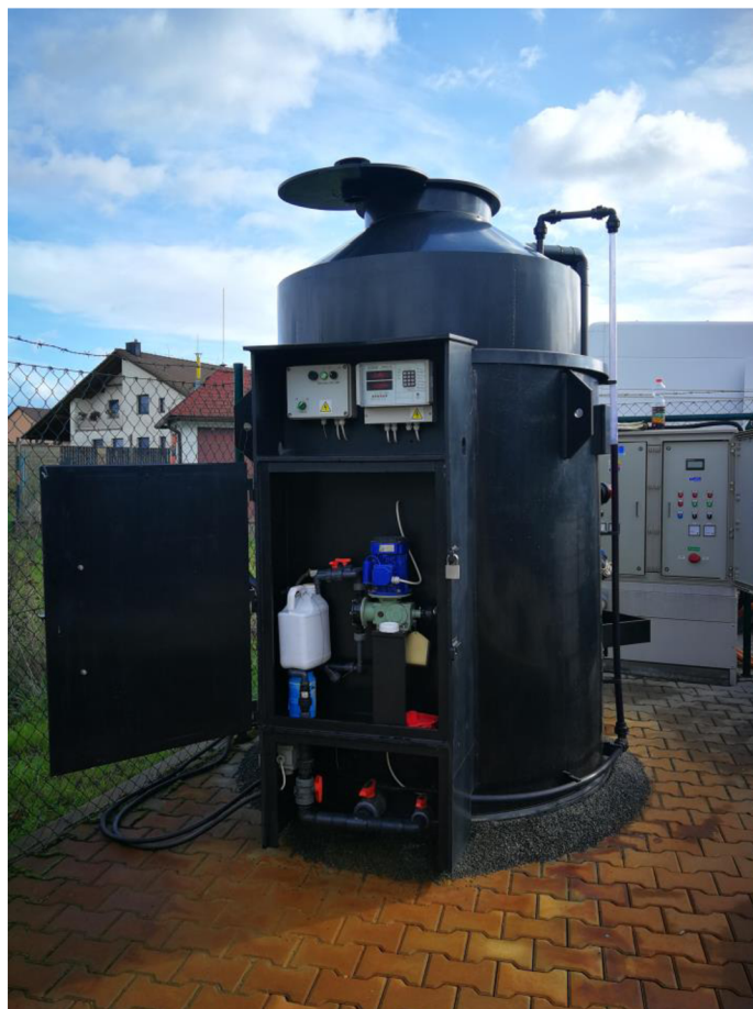
Obrázek 22 Dávkovací čerpadlo v Neslovicích
