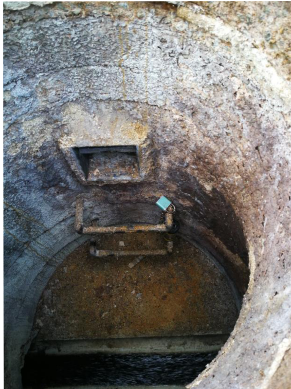
Obrázek 28 Pohled do šachty po připevnění detektoru
