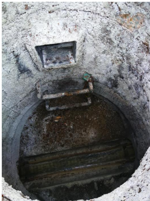
Obrázek 31 Kanalizační šachta v Rosicích 4. prosince 2019
