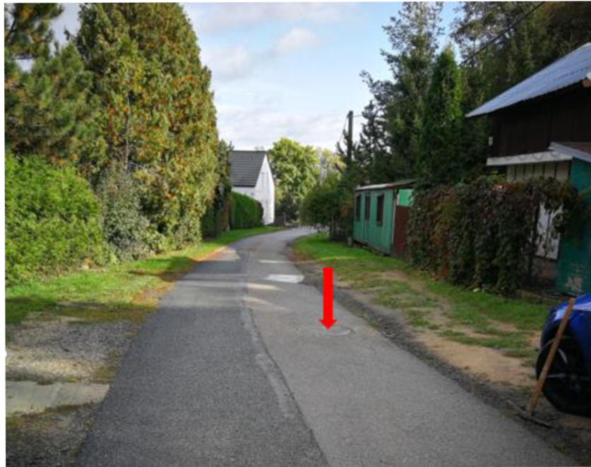
Obrázek 25 Šachta v Rosicích
