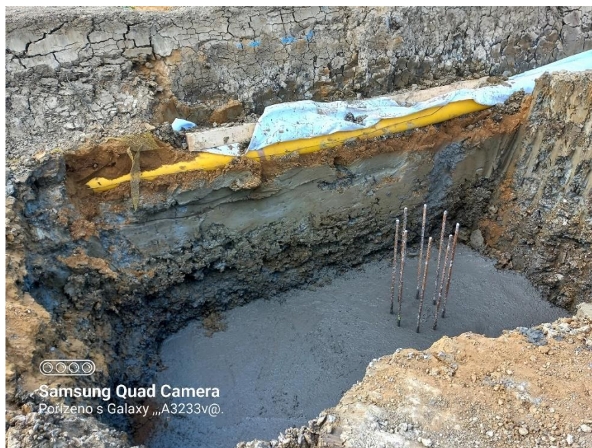
Obrázek 80 Betonáž pilot
