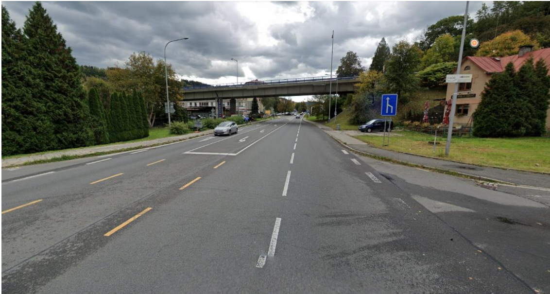
Obrázek 6 Podjezd pod silnicí č. 57 [15]
