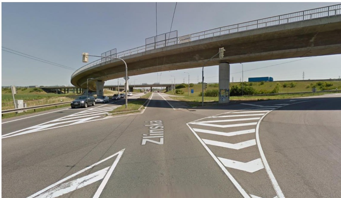
Obrázek 27 Podjezd pod mostem na silnici č. 49 [43]
