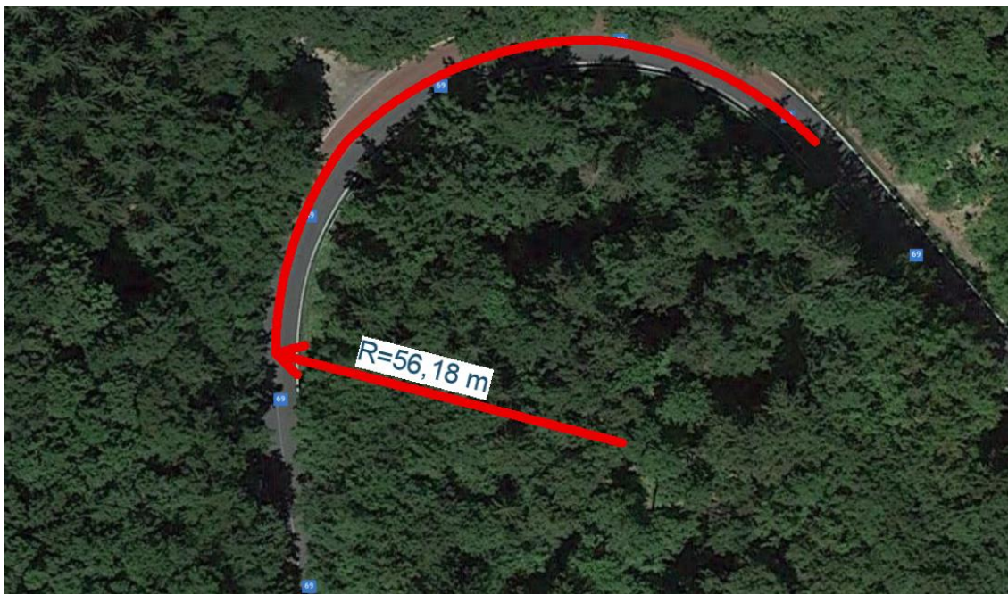
Obrázek 29 Oblouk na silnici č.69 [45]
