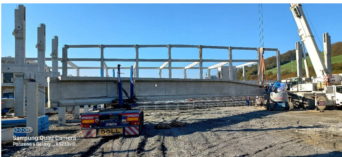
Obrázek 31 Doprava nosníku PR15a
