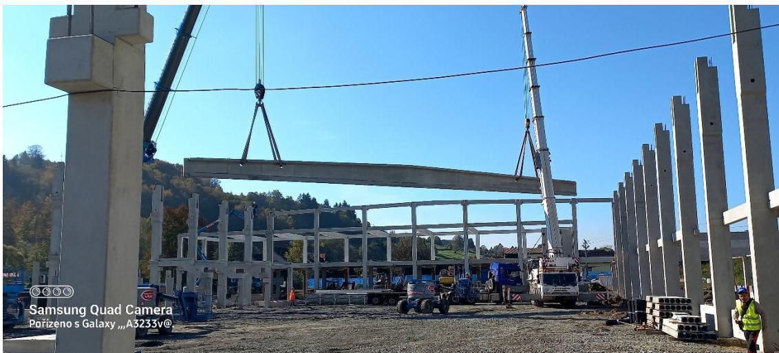
Obrázek 33 Doprava nosníku PR15a
