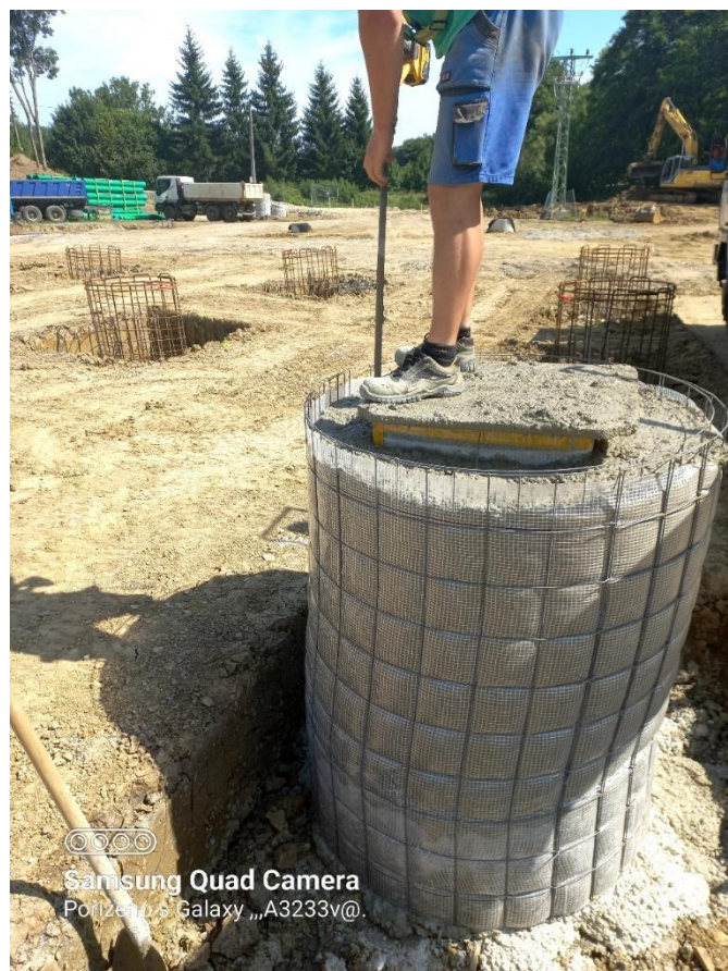
Obrázek 79 Betonáž pilot
