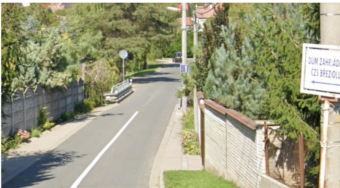
Obrázek 19 Most přes říčku Březnice v obci Březolupy [31]
