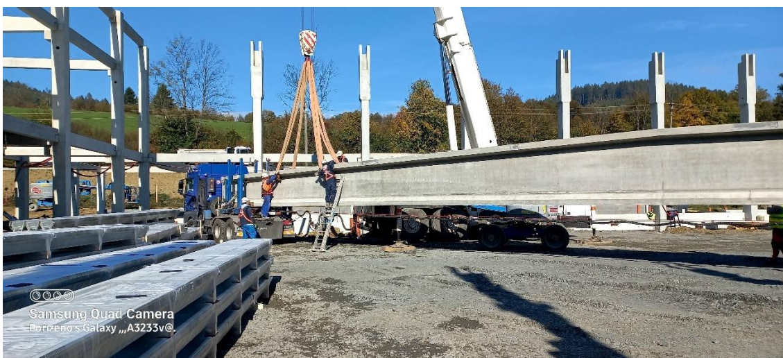
Obrázek 31 Doprava nosníku PR15a
