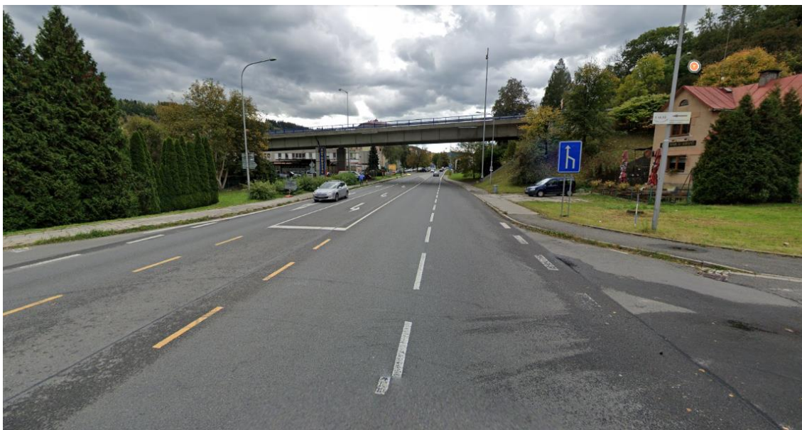
Obrázek 12 Podjezd pod silnicí č. 57 [22]
