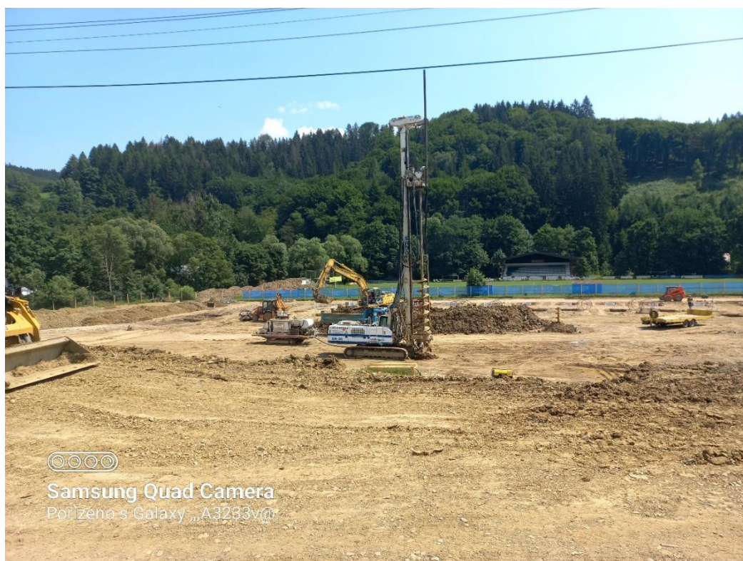
Obrázek 77 Provádění vrtů
