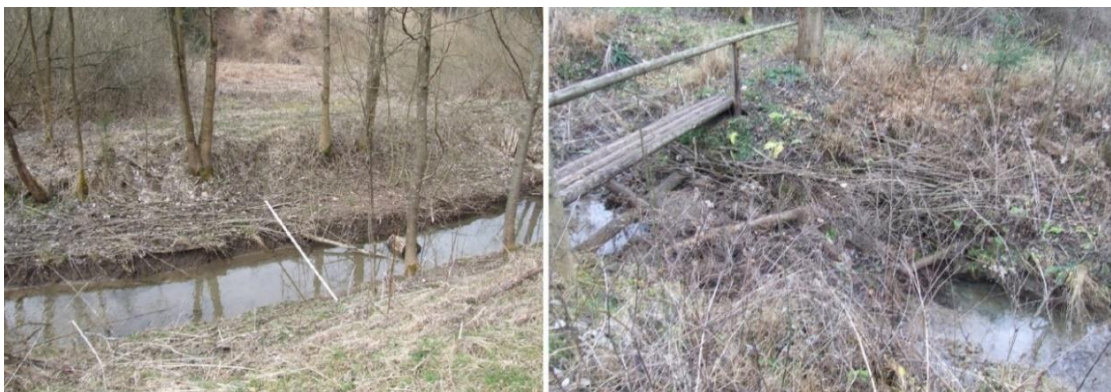
Obrázok 20: Vľavo stav vodného toku pred umiestnením dreveného stupňa, vzadu plocha pre rozptyl vody; vpravo realizovaný drevený stupeň
