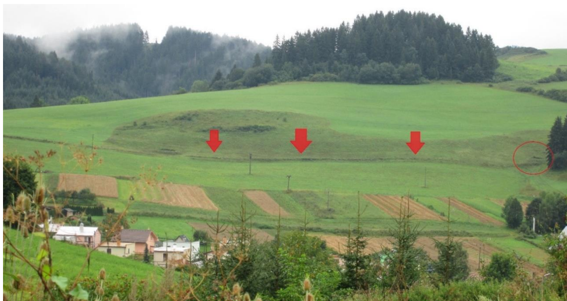
Obrázok 19: Vsakovacie ryhy v lokalite Náklo (červené šípky) a jazierko v lokalite Hríb (červený kruh), stav 3 roky po realizácii
