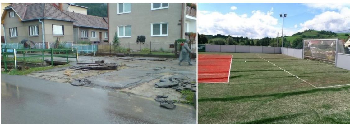
Obrázok 15: Škody spôsobené na cestnej komunikácii (vľavo) a na viacúčelovom ihrisku (vpravo) po povodniach v roku 2010
