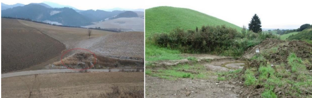
Obrázok 24: Vsakovacia jama – umiestnenie v krajine, stav 4 roky po realizácii (vľavo) a pohľad na vsakovaciu jamu tesne po výdatných dažďových zrážkach 3 roky po realizácii (vpravo)
