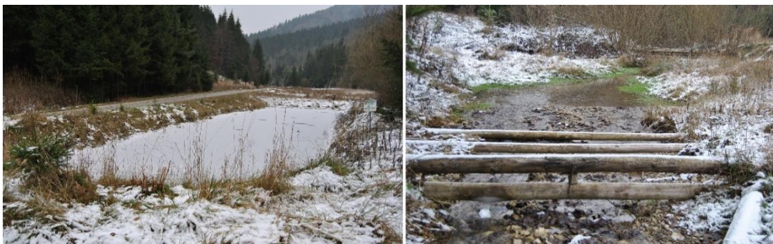
Obrázok 22: Jazierko s trvalou vodnou plochou (vľavo) a dvojité rámový priepust (vpravo) v Sklabinskej doline, stav po 4 rokoch
