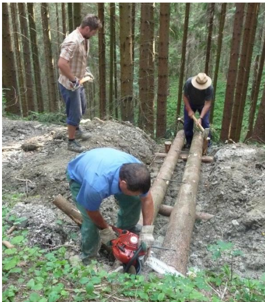
Obrázok 16: Realizácia odrážok na lesnej ceste
