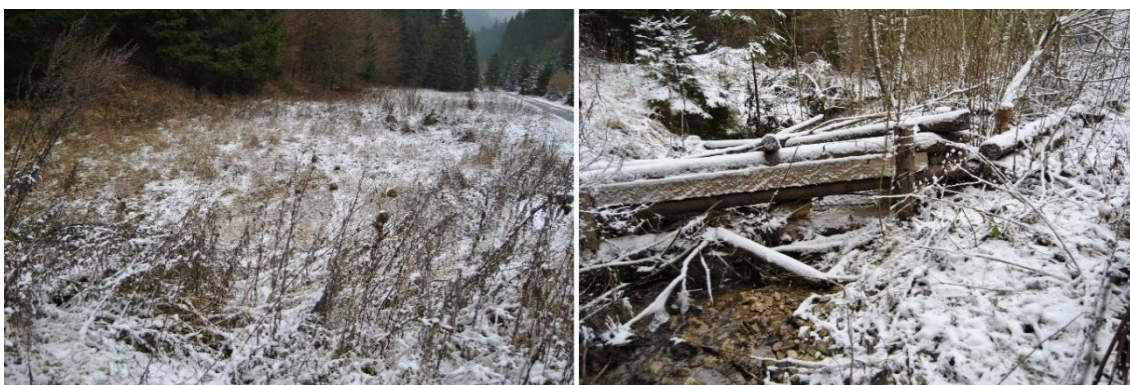
Obrázok 23: Lúčny pás medzi spevnenou cestou a lesom (vľavo) a vzdúvací objekt odvádzajúci vodu rúrovým priepustom z rúbaniska na lúčny pás
