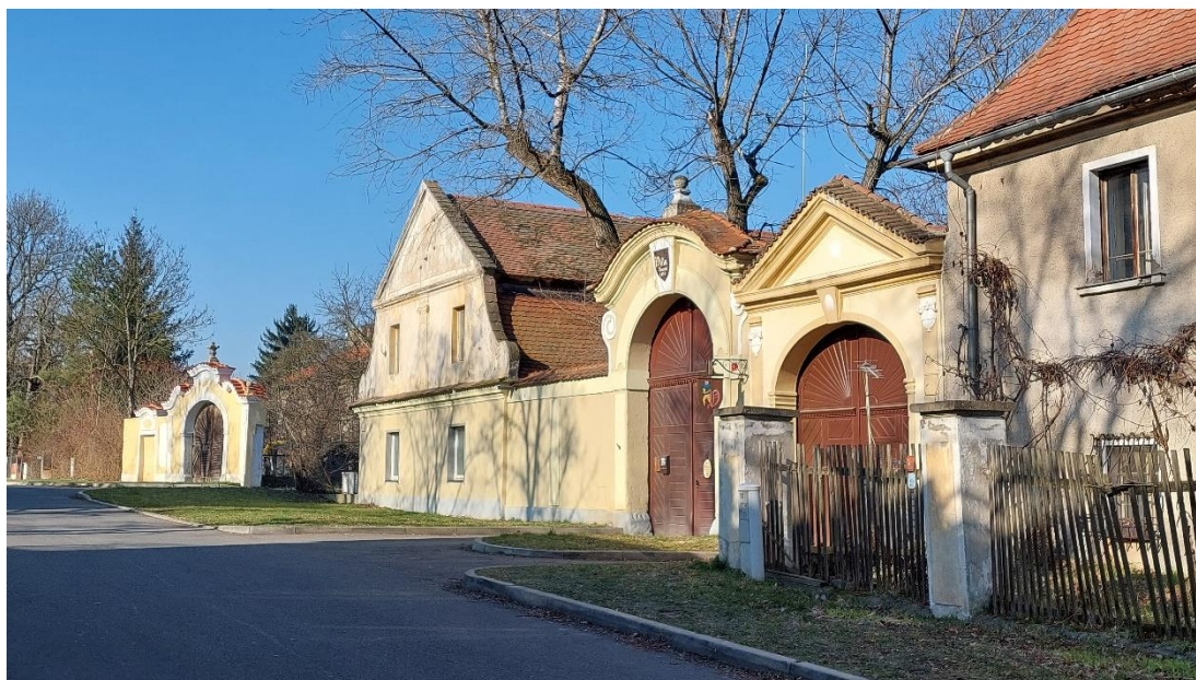
Obr. 10: Dochované historické struktury v Dřevčicích (Michaela Matoušková, 2023)
