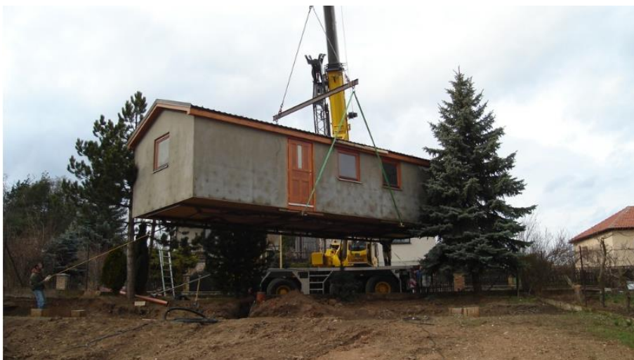
Obrázek 18: Vykládání mobilního domu
