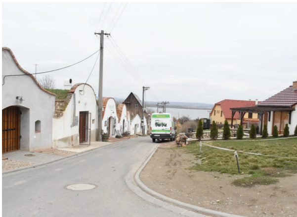
Obrázek 172: Tradiční vinařské sklepy v dolní části obce, 2017
