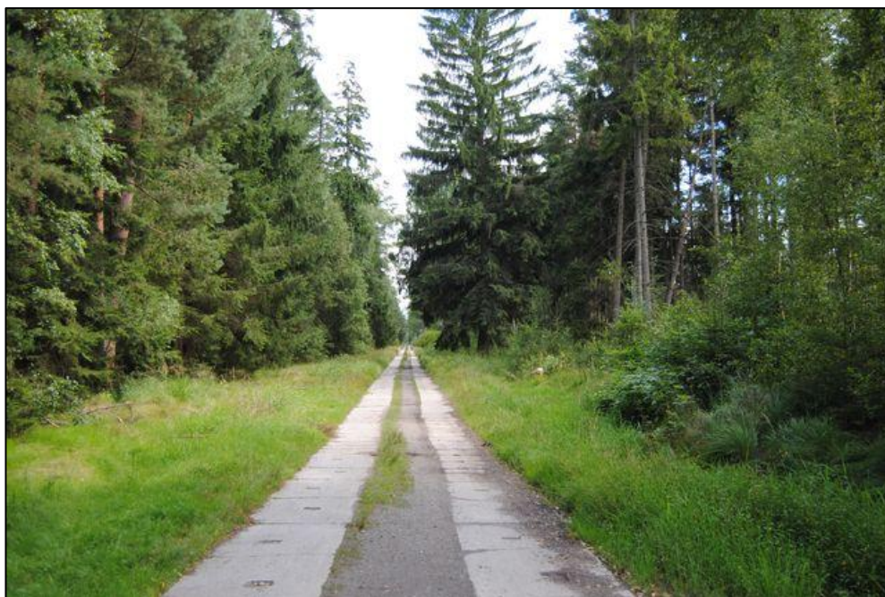
Obr. 7. – Stanoviště 4 – panelová cesta vedoucí okolo Sovího lesa
