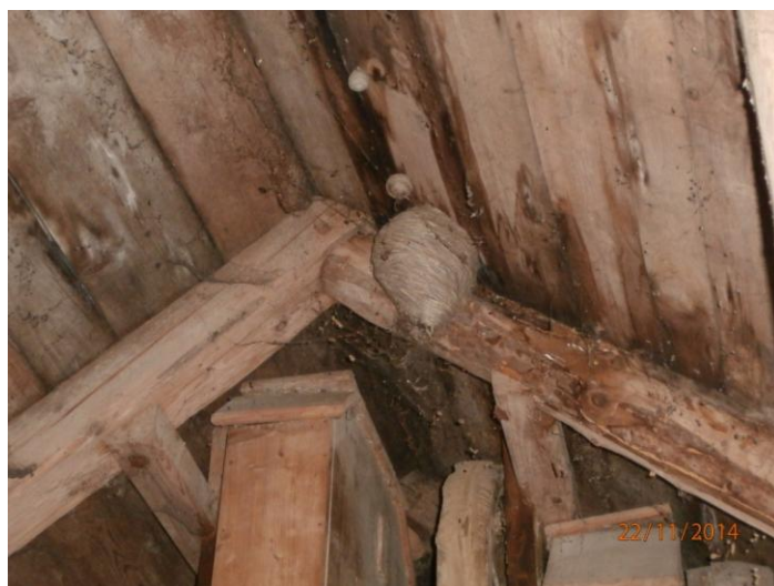
Obr. 51 Zatékání dešťové vody přes hřeben střechy
