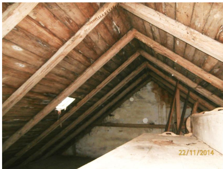
Obr. 31 Pohled na konstrukci krovu
