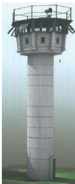
Obrázek 6: Pozorovací věž BT-11 , zdroj: ROTTMAN, Gordon L., Berlínská zeď a vnitroněmecká hranice 1961 - 1989 : 13. srpna 1961 - 9. listopadu 1989, Praha: Grada, 2009. ISBN 978-80-247-2879-7.
