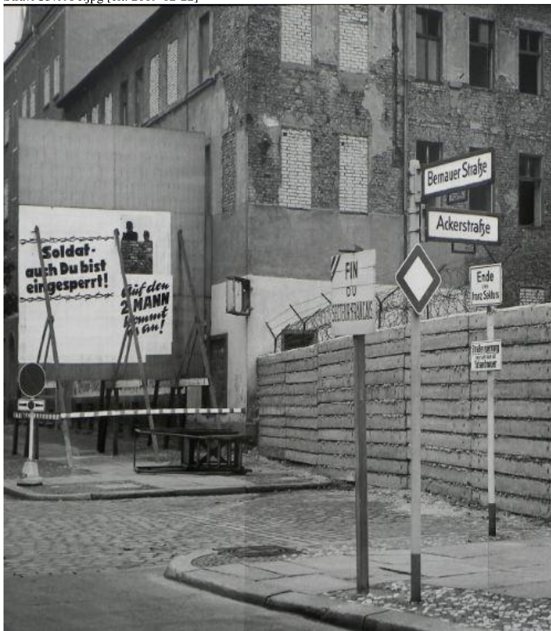
Příloha 5: Zazděná okna domů a provizorní zed' z betonových panelů, zdroj: WIKIPEDIA, Acker-Bernauer Straße, [online], https://upload.wikimedia.org/wikipedia/commons/3/3b/Acker-_Bernauer-Stra%C3%9Fe.jpg [cit. 2019-02-22]
