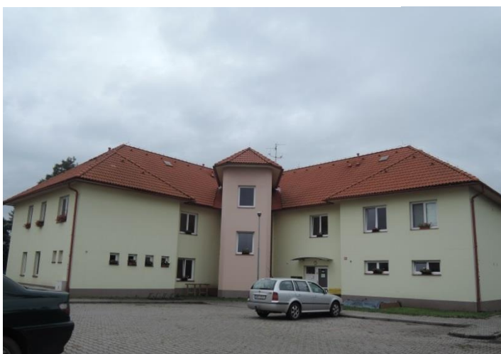
Obrázek č. 12: Bytový dům č. p. 505
