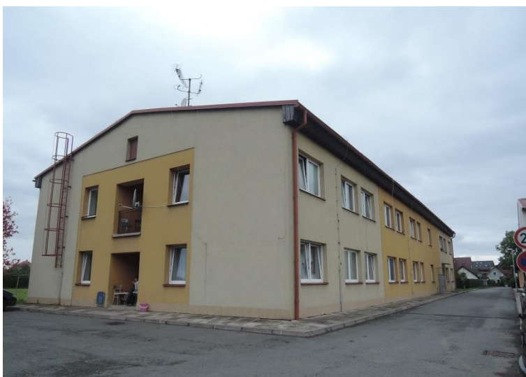
Obrázek č. 10: Ubytovna č. p. 296
