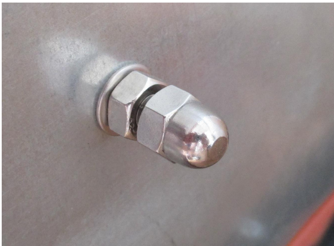
Obr. 2.11 Uzavření závitové tyče kloboukovou maticí.
