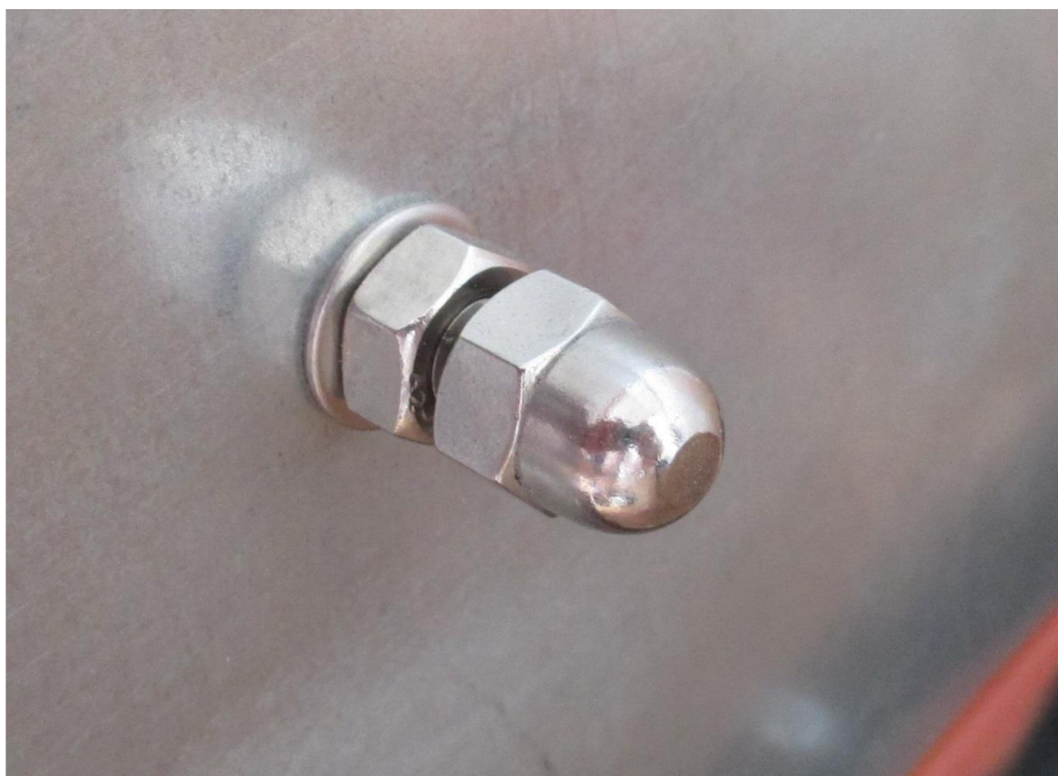
Obr. 2.11 Uzavření závitové tyče kloboukovou maticí.
