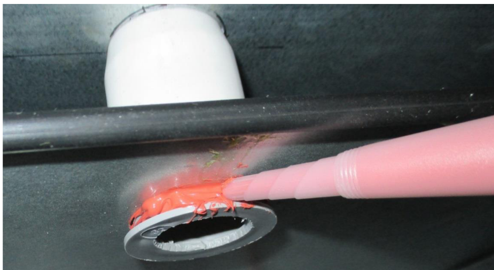
Obr. 3.6 Aplikace silikonového tmelu mezi zátku a plášť komory.
