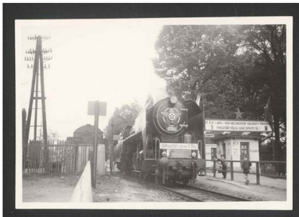
Zábrdovické nádraží. Foto z archivu města Brna. (zdroj: https://www.gotobrn.cz/wp-content/uploads/2021/06/amb_foto_amb_u5_xib-163_001-scaled.jpg )
