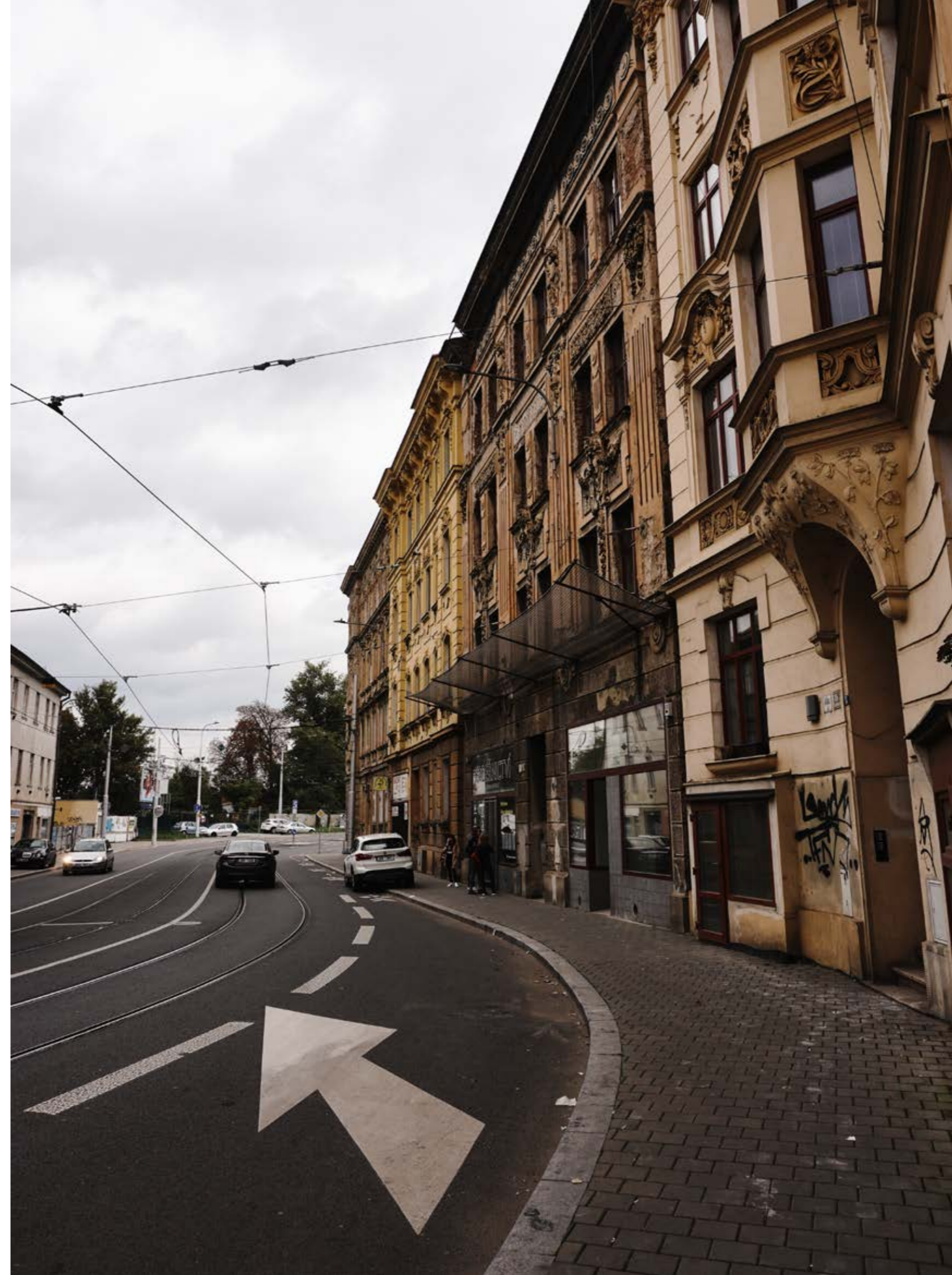
Ulice Cejl z pohledu směrem na Zábrdovický most.
