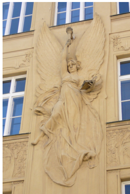
Obr. 15. Detail fasády budovy Vesny na Jaselské ulici 23
