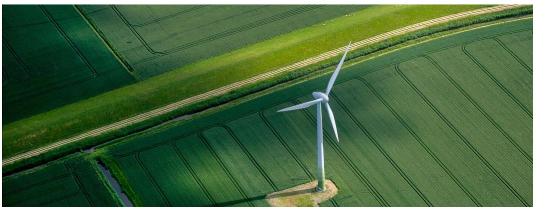
Obr. č. 3 – Vztlaková větrná elektrárna [5]
