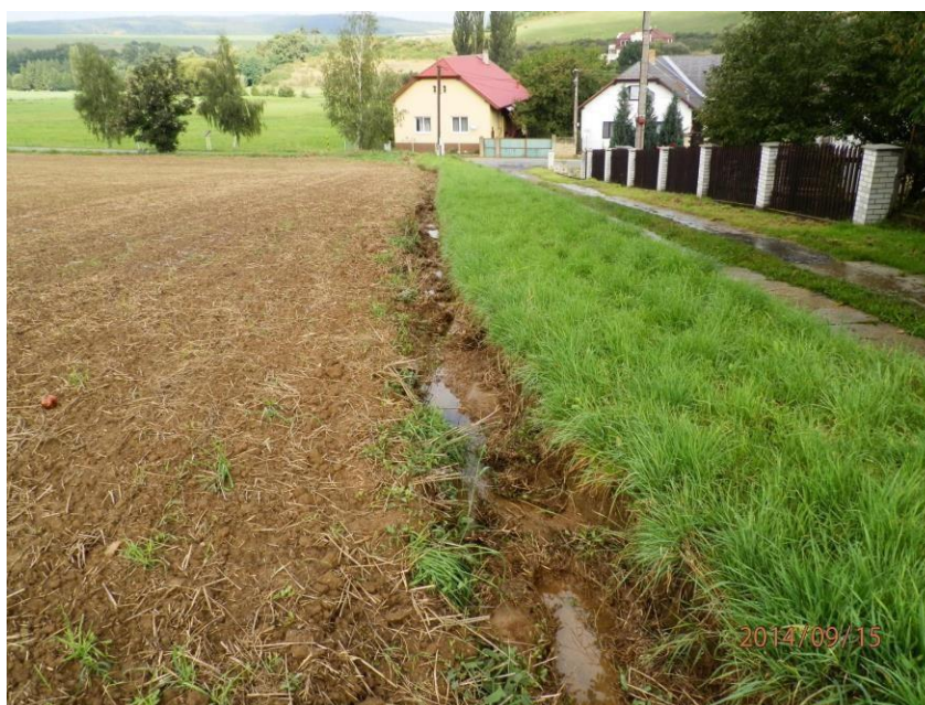
Foto č. 5 Detail odtokové brázdy
