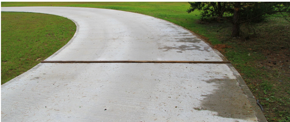
Obr. 6.3: Instalovaná překážka určená pro vybuzení kmitů
