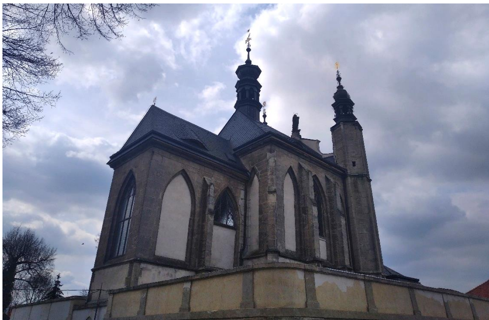
Obrázek č. 8: Kostel Věch svatých
