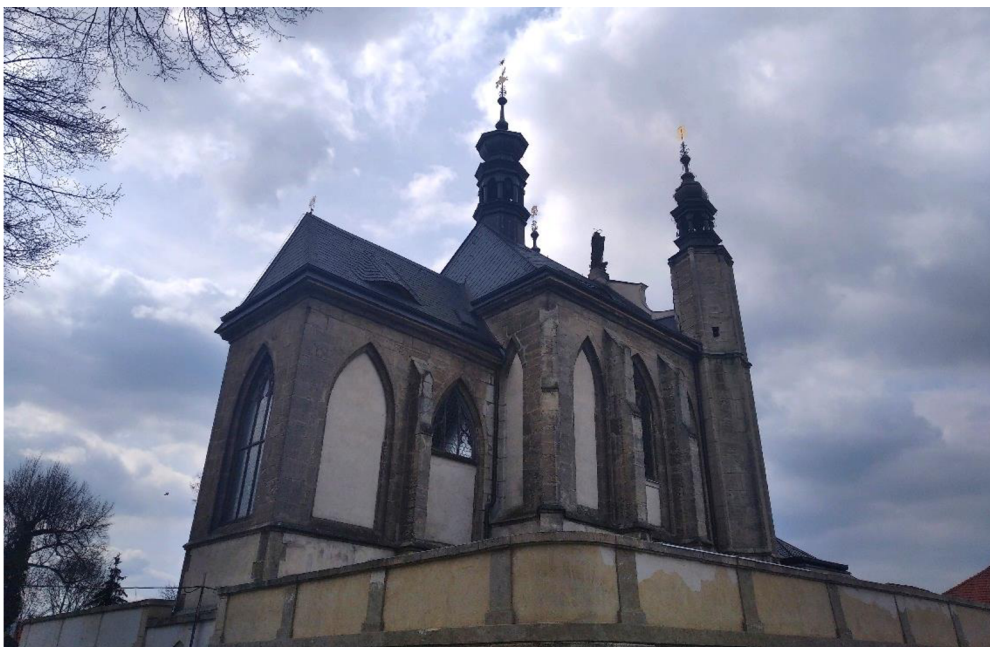
Obrázek č. 8: Kostel Věch svatých
