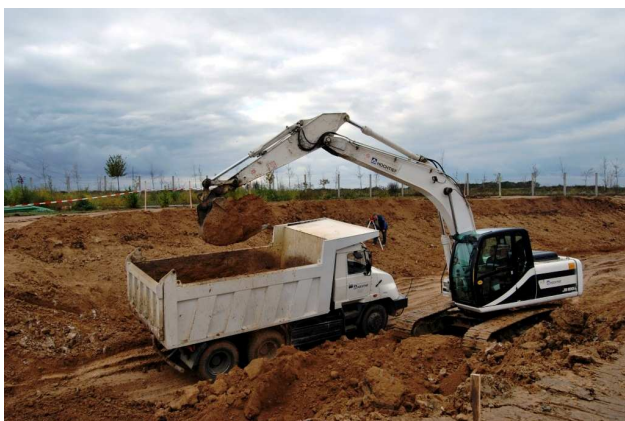
Foto 4.2 Úprava tělesa skládky. K manipulaci se zemínou a odpadem se využívá buldozer značky Hochtief.
