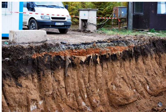
Foto 4.4 Vrstvy podloží. Z fotografie jsou dobře patrné jednotlivé vrstvy podloží, především jílovitá vrstva a geotextilie. (Zdroj: Autor)
