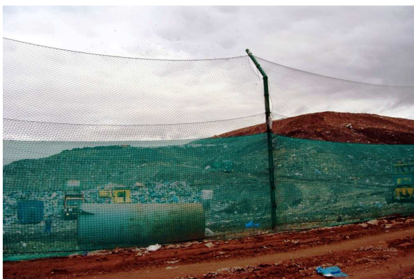
Foto 4.9 Záchytné síť. Z důvodu úletu lehkých částí odpadů byly podél areálu skládky vybudovány 5ti metrové přenosné síťe. (Zdroj: Autor)
