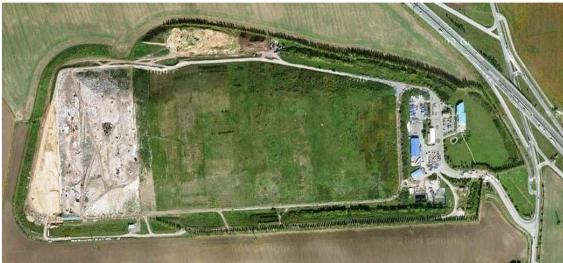
Foto 7.1 Letecký snímek. Z fotografie je dobře patrný přechod mezi zrekultivovanou částí skládky a částí dosud aktivně využívanou. (Zdroj: maps.google.cz)
