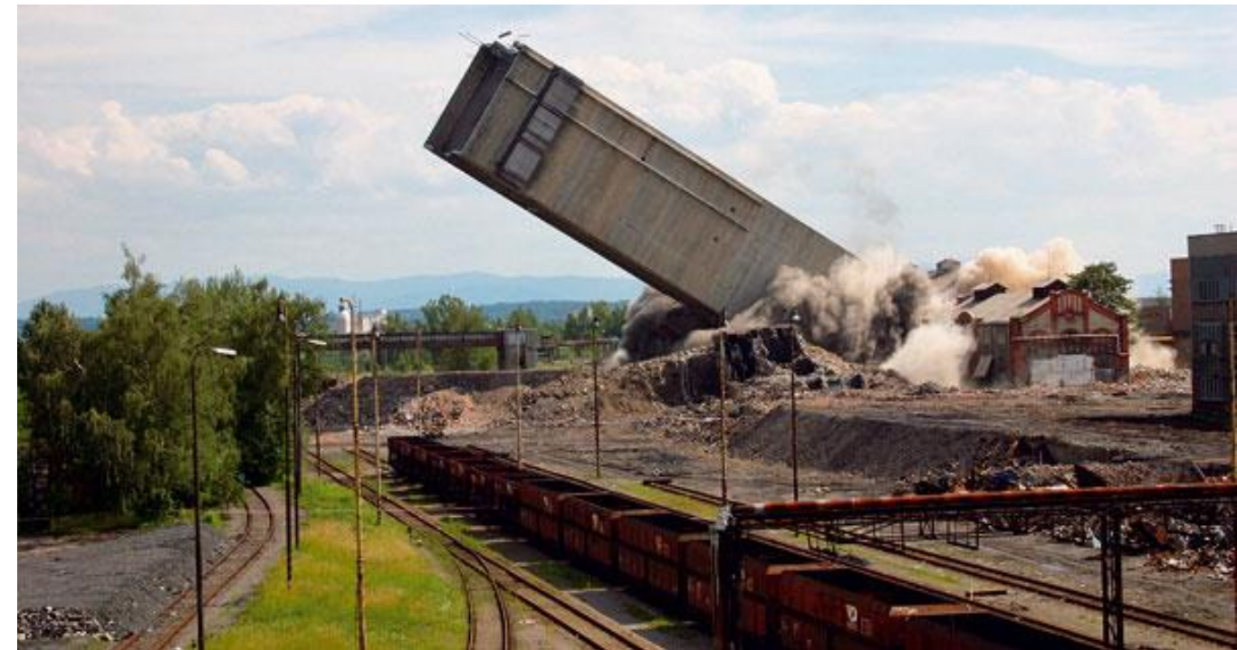
Obrázek 19-odstřel skipové těžní věže na dolu Dukla 19.června 2008 (foto Jiří Doležal, dostupné z: https://www.asb-portal.cz/wp-content/uploads/images/ilustracne/odstrel_skipove_tezni_veze_na_dole_dukla.jpg )
