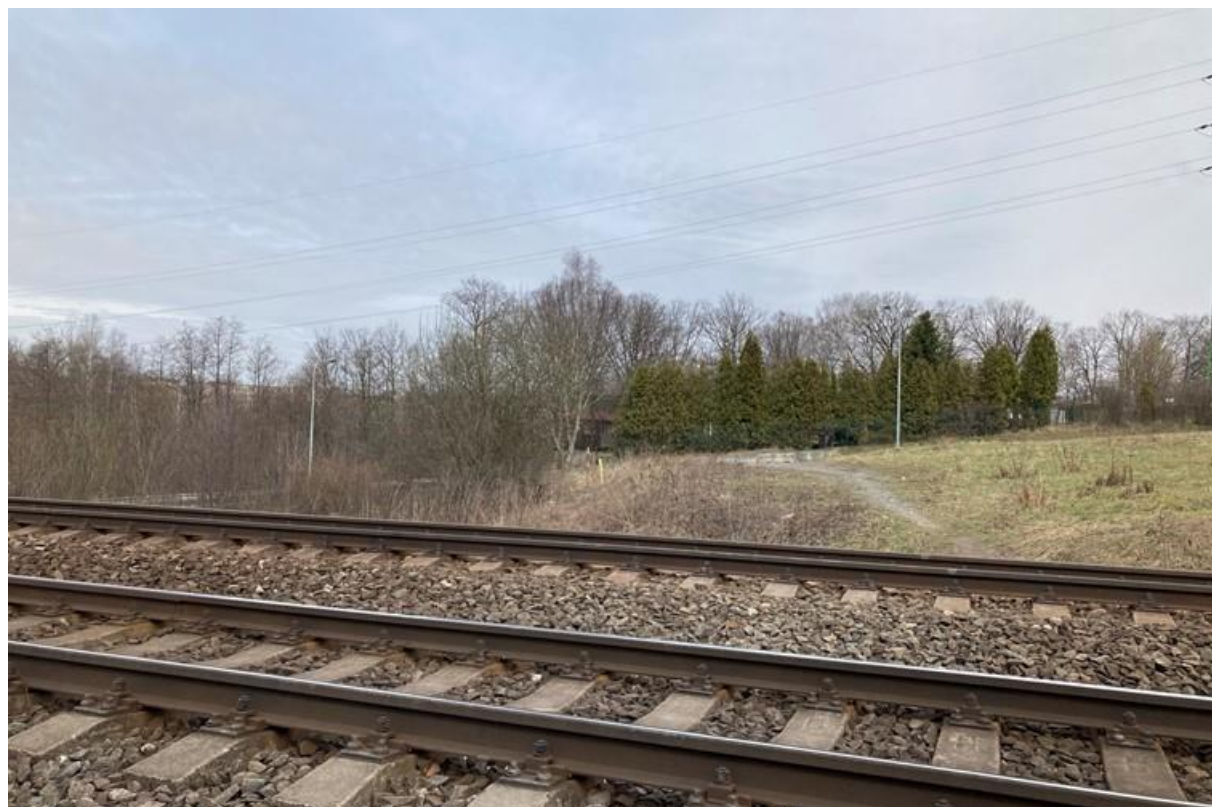
Obrázek 51-pohled na terén problémové situace, v pozadí ulice U Skleníků (autor, březen 2021)
