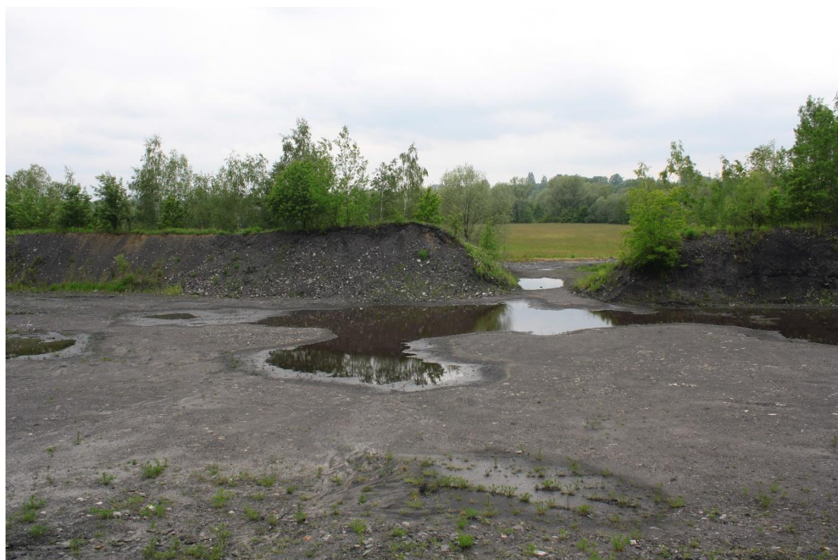
Obrázek 35-průhled z prostoru B na zasypanou nádrž č. 7 (autor, květen 2020)
