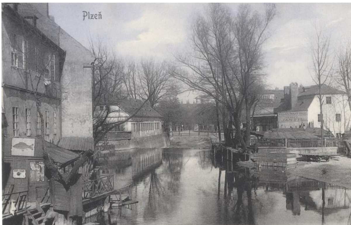
Obrázek 3: Mlýnská strouha, foto (1906), pohlednice (Archiv města Plzně)
