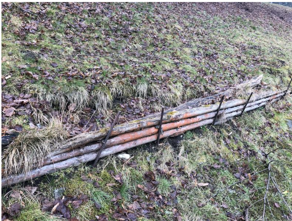
Obrázek 25: Improvizovaná zábrana proti erozi ve svahu břehu (Rauch, J., 2021)
