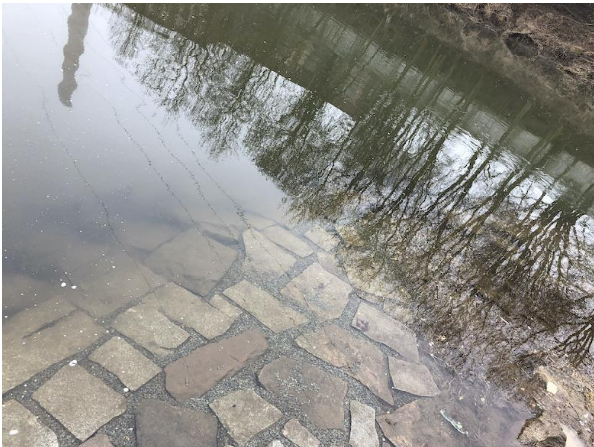
Obrázek 23: Zpevnění břehu v místě soutoku (Rauch, J., 2021)
