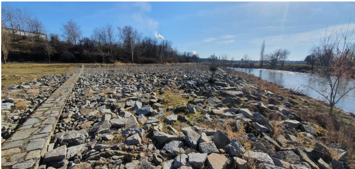
Obrázek 33: Kamenný pohoz na břehu Berounky (Hájek, J., 2021)
