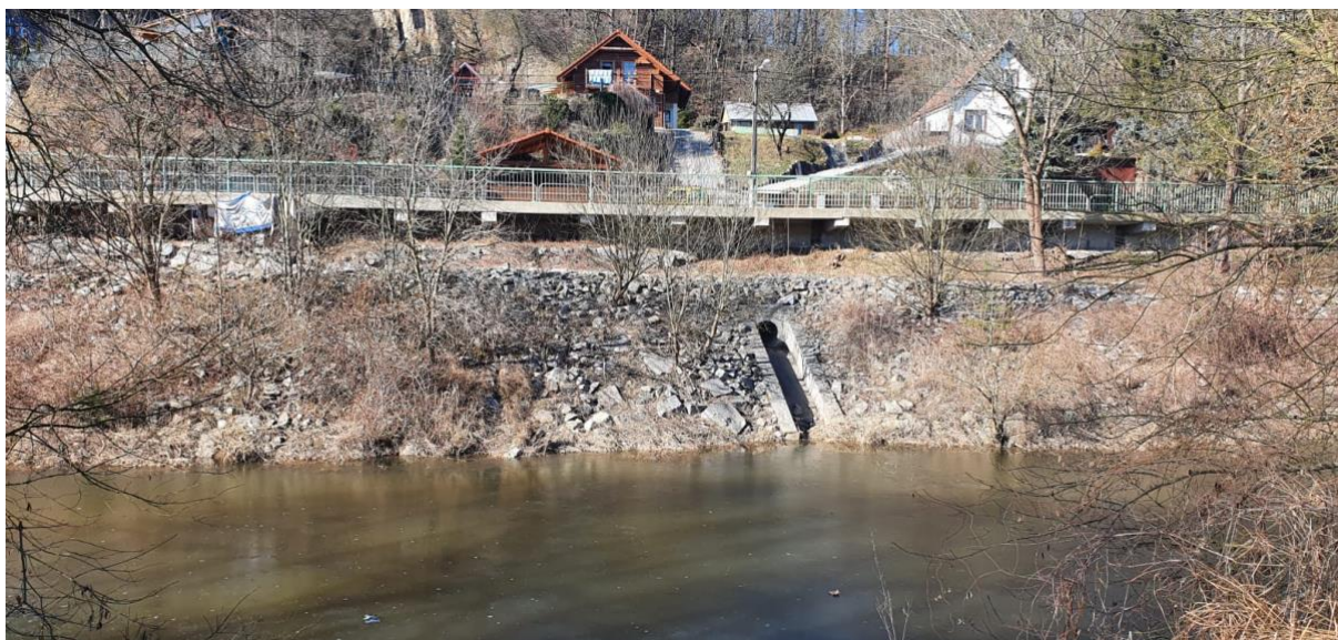
Obrázek 31: Opevnění břehu umělého říčního ramene pod komunikací Na Roudné (Hájek, J., 2021)
