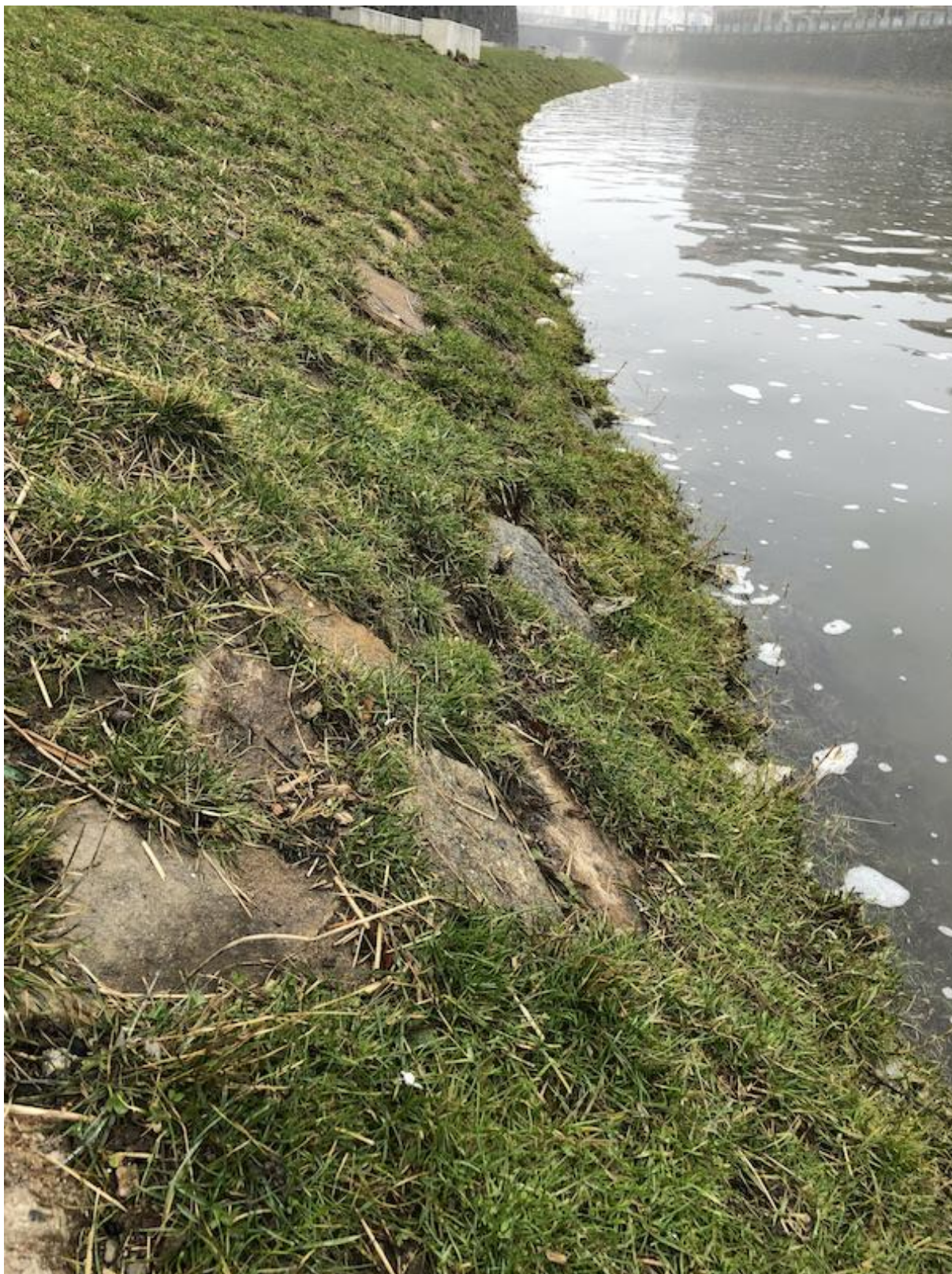
Obrázek 35: Náplavka na Radbuze, kombinace umělého a vegetačního opevnění (Rauch, J., 2021)
