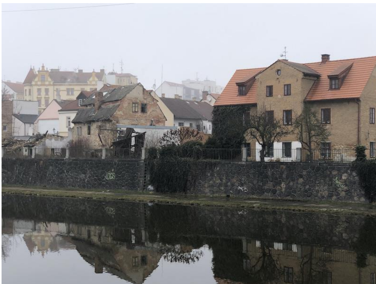
Obrázek 27: Poničené budovy na levém břehu řeky Mže (Rauch, J., 2021)
