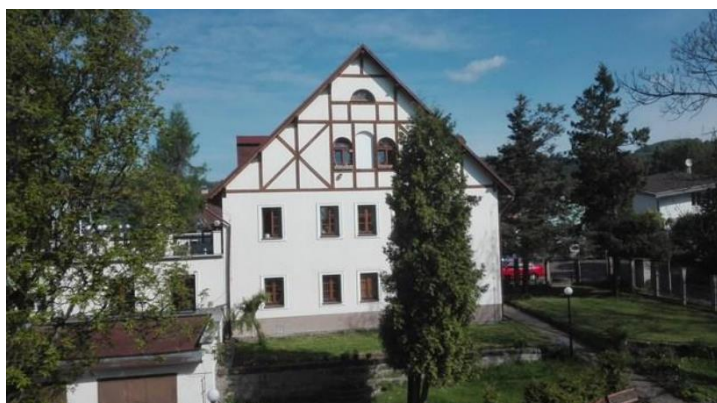
Obrázek 7. Budova „C“ s prostory denního stacionáře „Meduňka“
