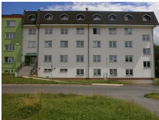
Obrázek 9. Pohled na budovu domova důchodců Zákupy
