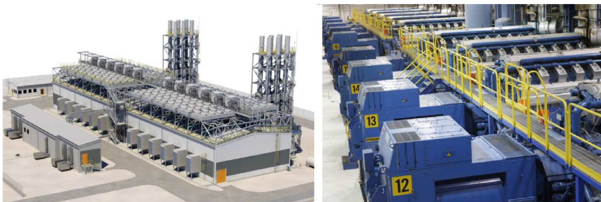
Obr. 1 Elektrárna se spalovacími motory o výstupním výkonu 100 MW el [24]
