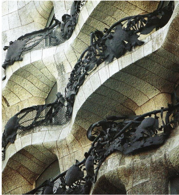
Obr. 39: Balkóny na stavbě Casa Milà
