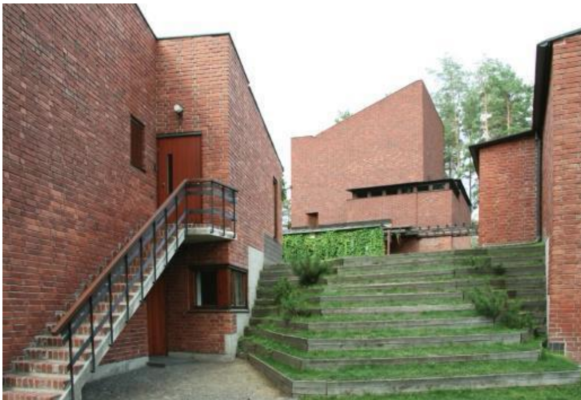
Obr. 95: Tráva na schodišti propojující pavilony městečka Säynätsalo
