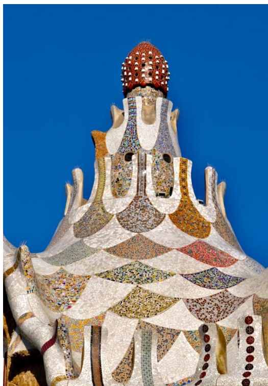
Obr. 136: Střecha administrativní budovy při vchodu do Parku Güell
