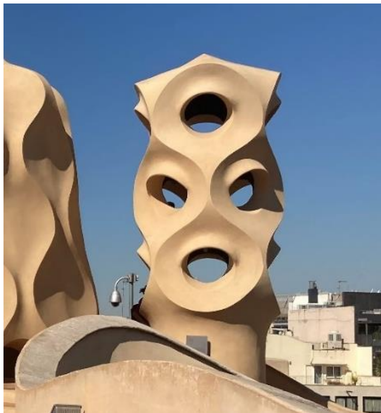
Obr. 137: Střešní terasa s komíny na stavbě Casa Milà
