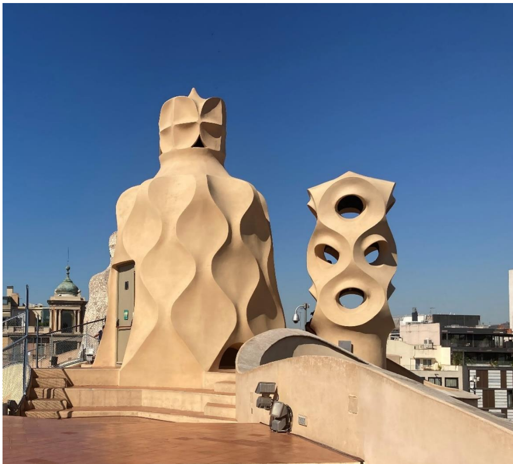
Obr. 40: Zakončení střechy Casa Milà
