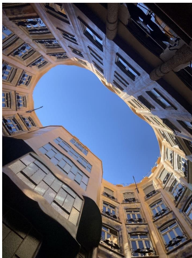
Obr. 36: Průhled oválným dvorem, Casa Milà
