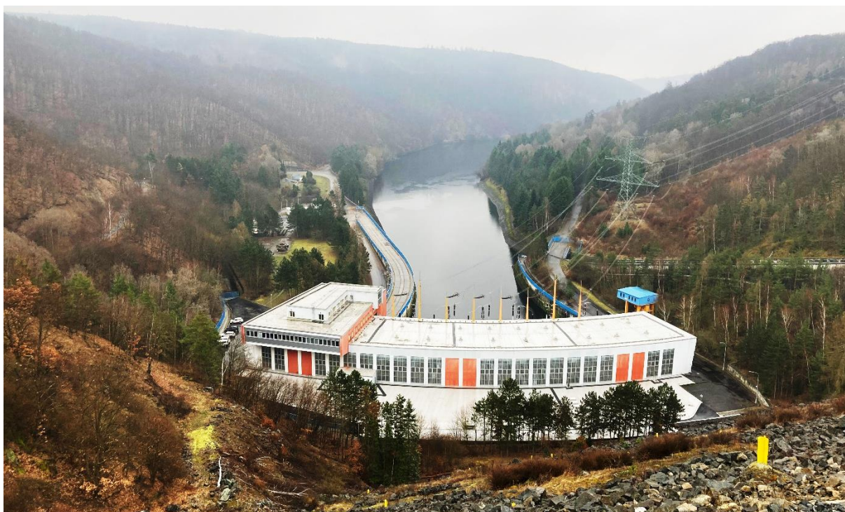
Obr. 10: Přečerpávací vodní elektrárna Dalešice, pohled z hráze
