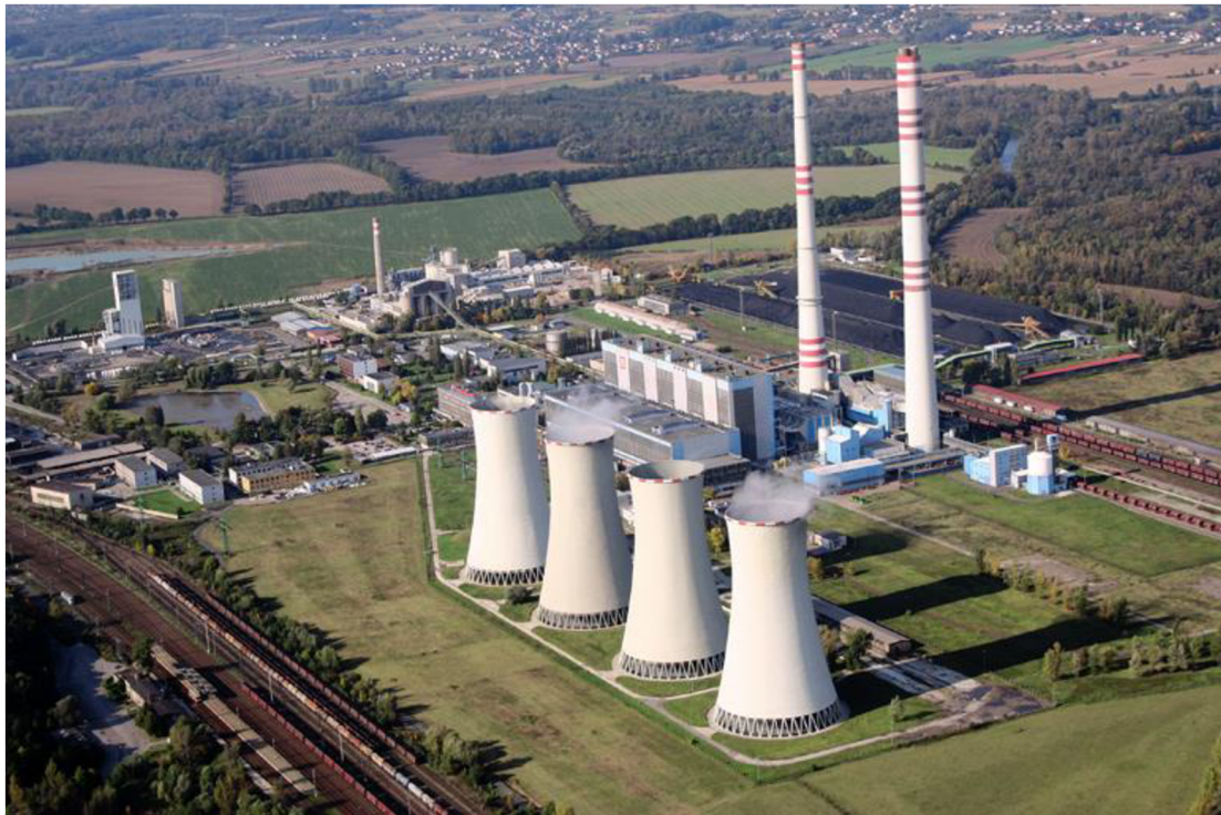
Obr. 6: letecký pohled na tepelnou elektrárnu Dětmarovice
