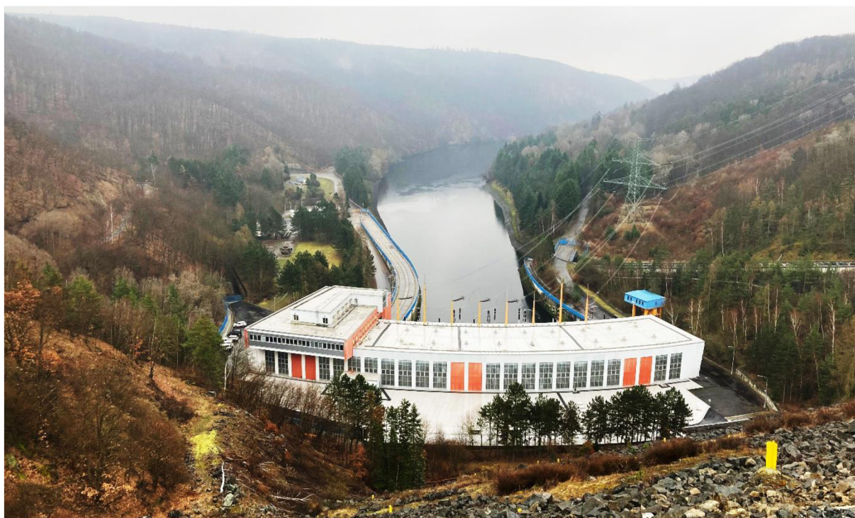
Obr. 10: Přecherpávací vodní elektrárna Dalešice, pohled z hráze
