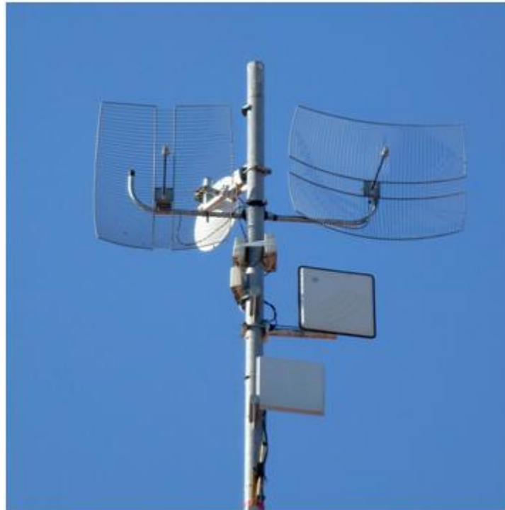
Obrázek 6: Stožár se sektorovými a směrovými anténami
