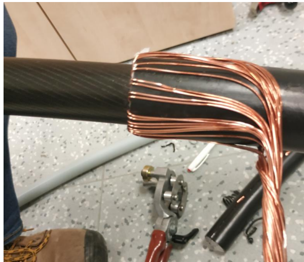
Kabel po sejmutí pláště
