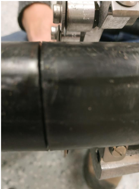
Sejmutí pláště kabelu
