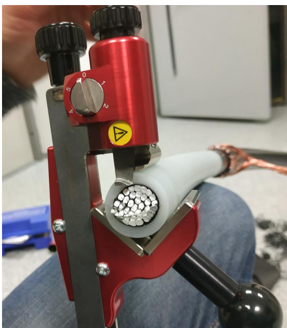
Odstranění izolace kabelu
