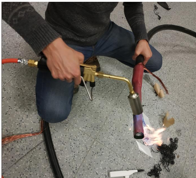
Ohřev kabelové koncovky
