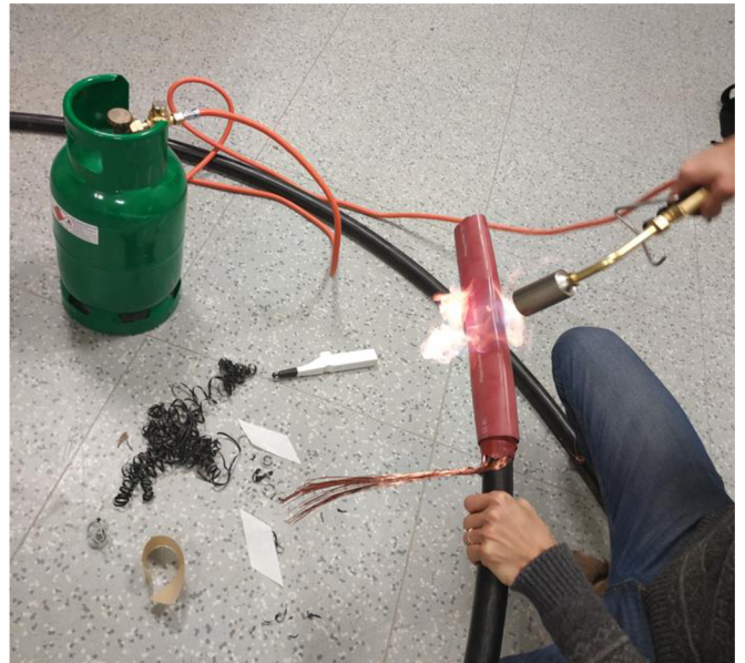
Ohřev kabelové koncovky
