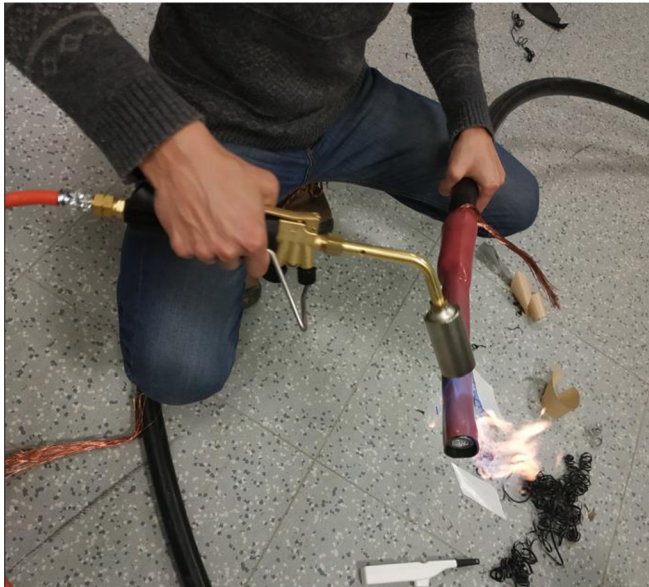
Ohřev kabelové koncovky
