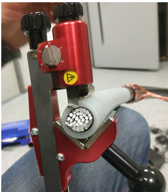
Odstranění izolace kabelu
