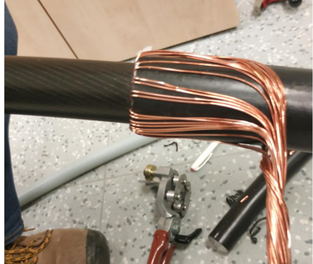
Kabel po sejmutí pláště
